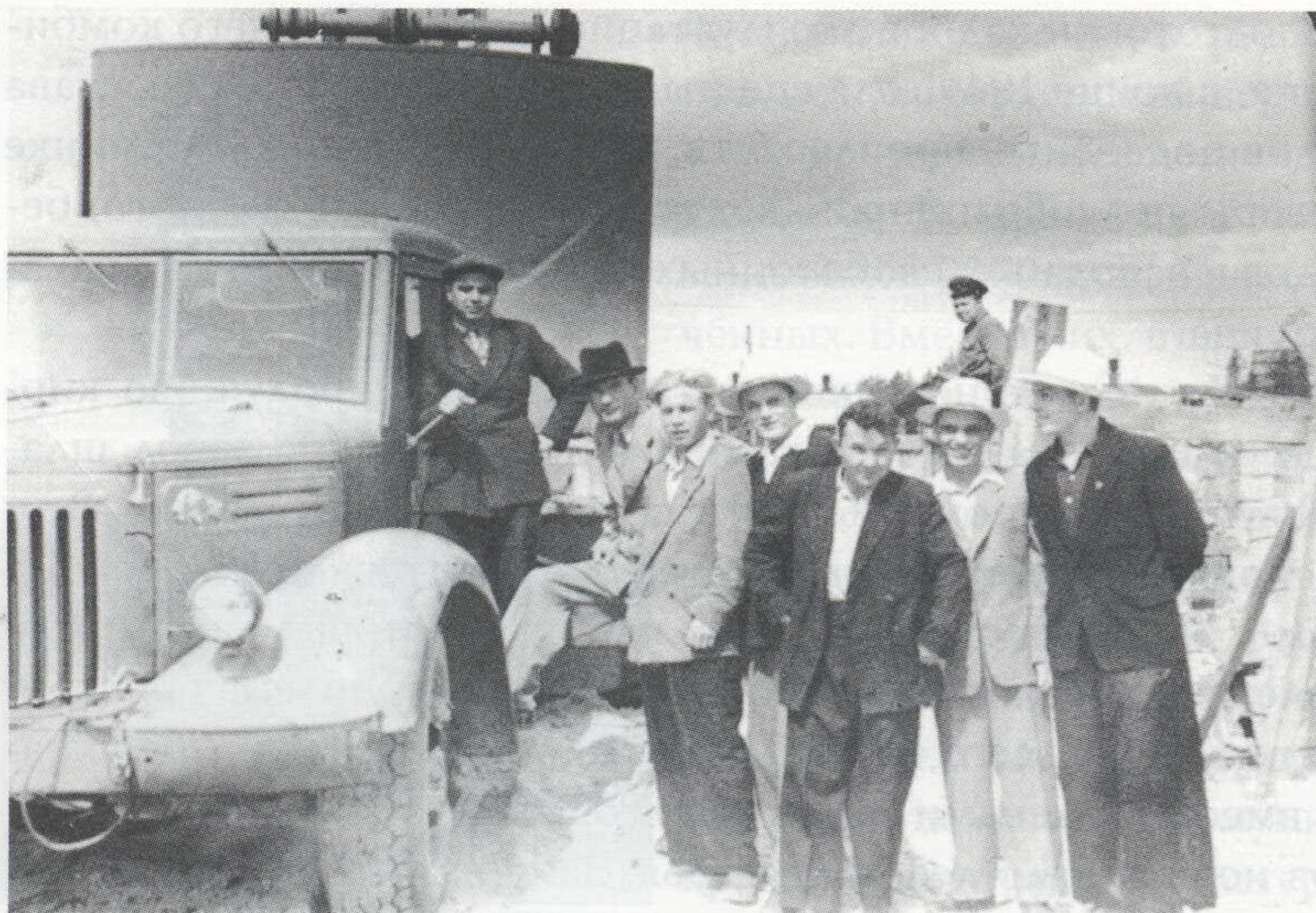
Рис. 82. На строительной площадке промзоны. 1950-е годы. Предоставлена Г.Н. Томиловой.
