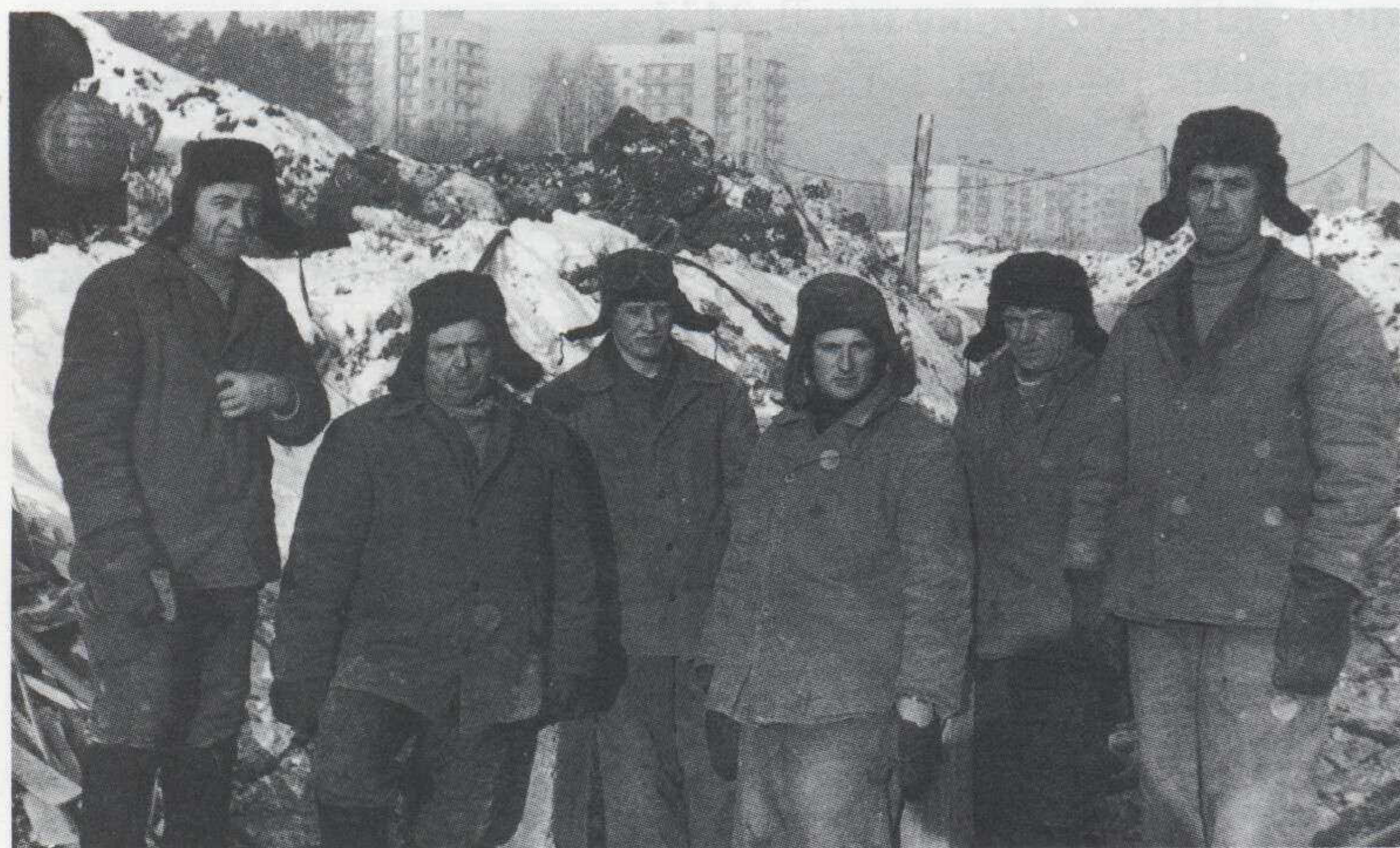
Рис. 95. Бригада трубоукладчиков СМУ-5 признана лучшей бригадой министерства по итогам 1975 года. Бригадир Ф.Г. Галушак, второй слева. Из фондов Музея г. Северска.
