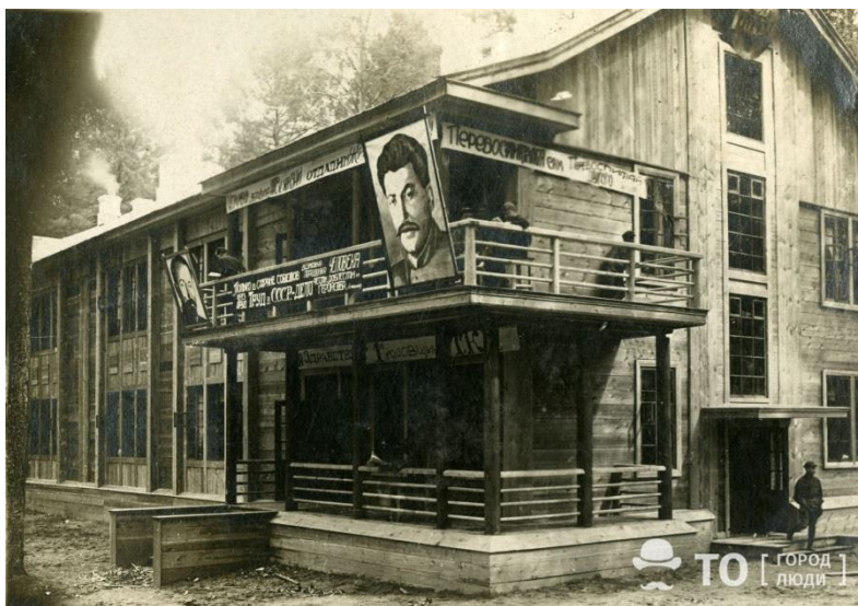
Главное административное здание ТКМ "Чекист". 1935 год Фото из фондов МБУ «Музей г. Северска»
