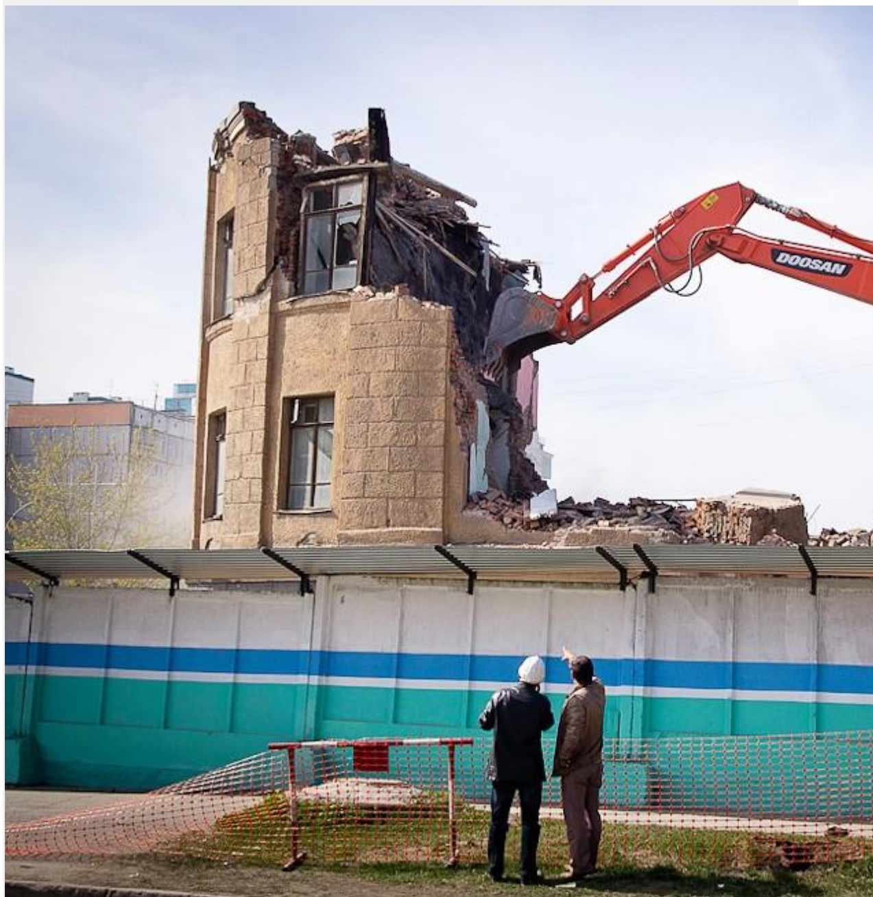
Снос здания бывшей пересыльной тюрьмы. Новосибирск, угол ул. Нарымской и ул. 1905 года.
