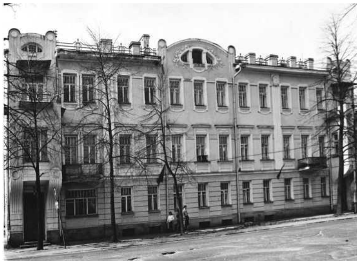
Здание Ярославского ОГПУ, ул. Собинова, д. 48, бывший дом Санина
