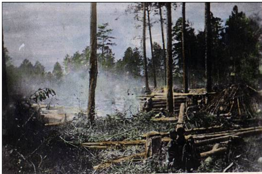
Строительство временных землянок
