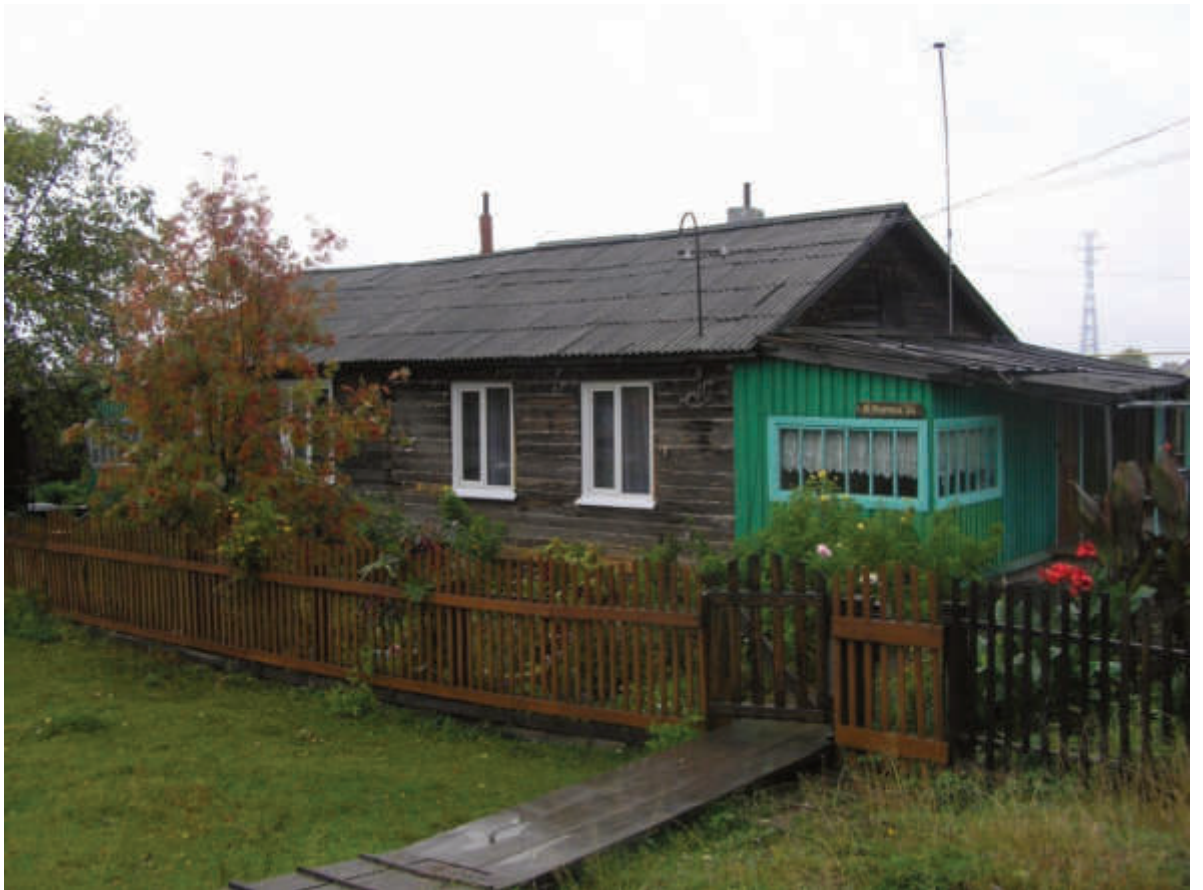
Дом с палисадником. Вход с двух сторон, т.е. на две семьи. Улица К. Маркса, 24
