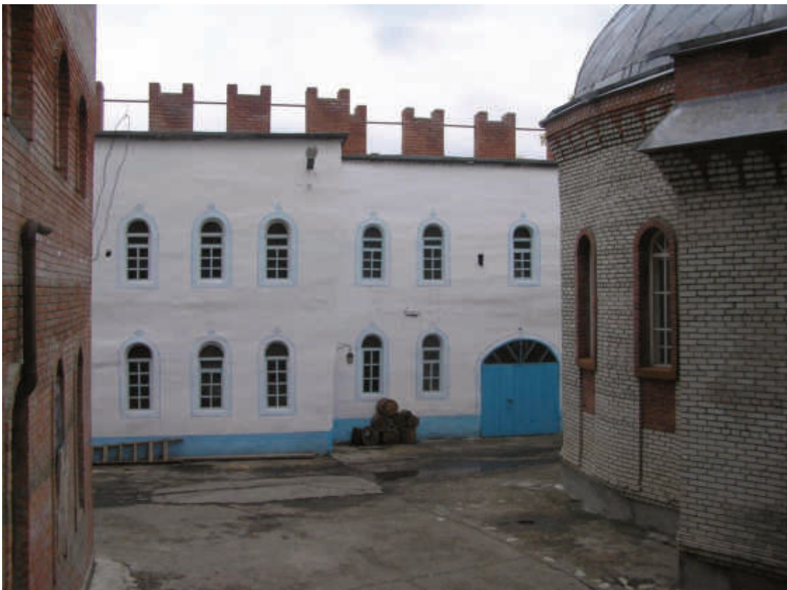
Справа просматривается стена храма
