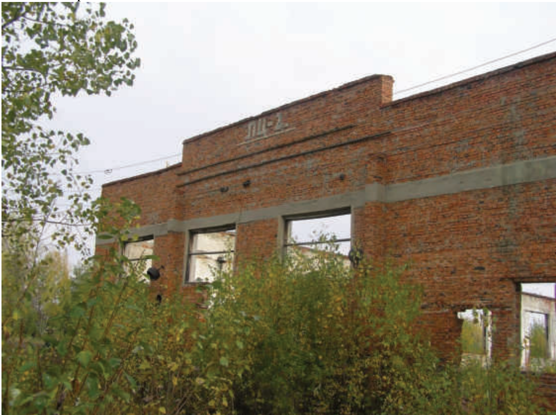
Фрагмент стены лесоцеха № 2 с замечательной кирпичной кладкой
