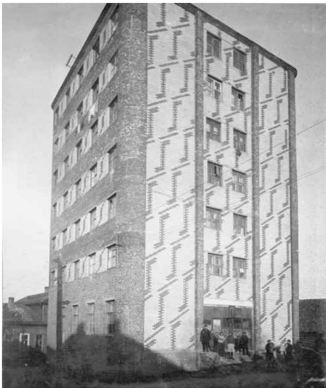
Дом РЖСКТ «ТРУД» Башня-коммуна Почтамтская ул.
