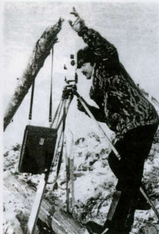
Строительство дороги на Северный Васюган
