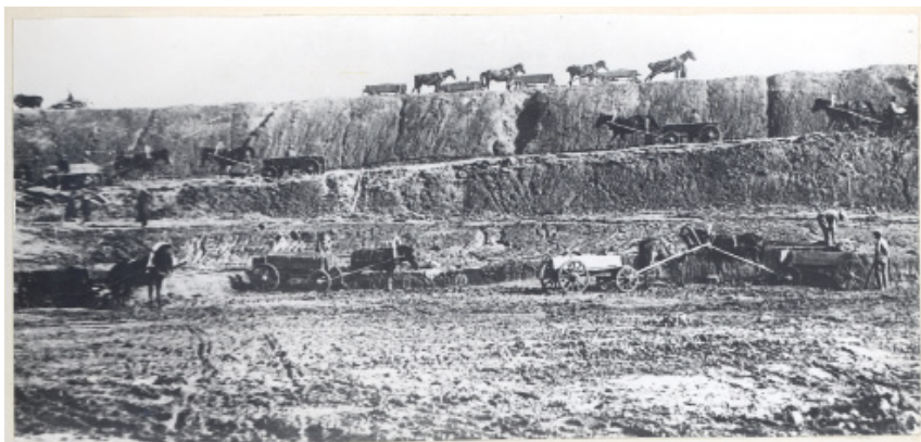
Использование гужевой силы на строительстве дороги Москва – Минск
