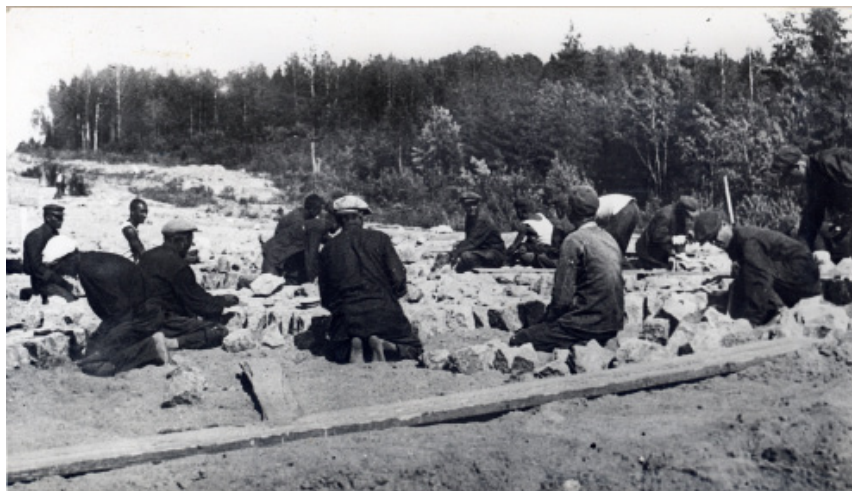
На сооружении шоссе Москва – Минск
