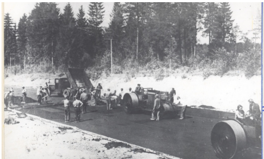
Устройство асфальтобетонного покрытия шоссе Москва – Минск. 1940 г.
