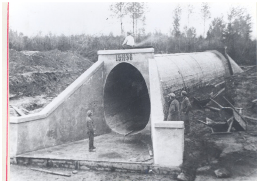
На сооружении шоссе Москва – Минск. 1936 г.
