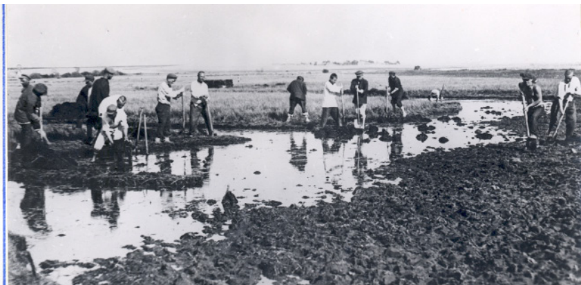
На строительстве автомагистрали Москва – Минск
