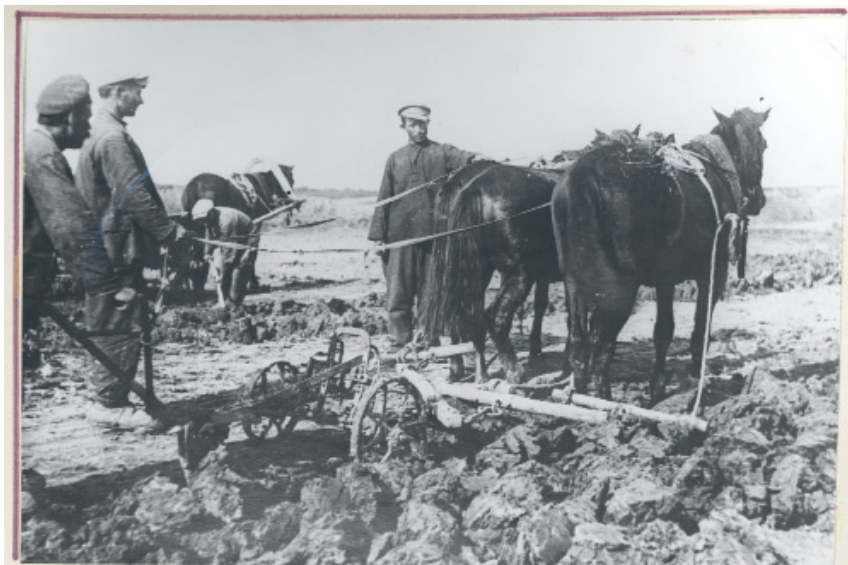
Снятие земляного слоя на сооружении магистрали Москва – Минск. 1936 г.
