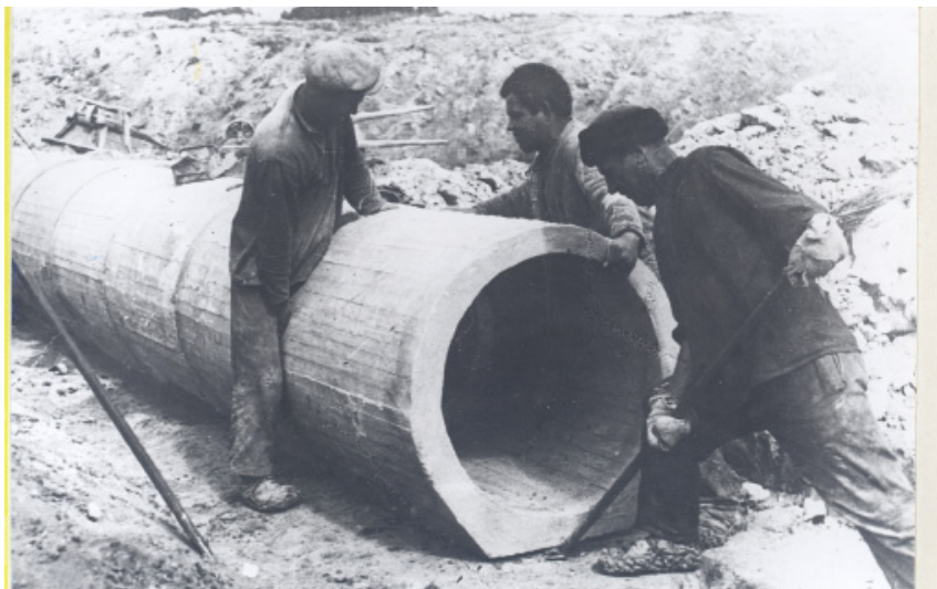
Работы по устройству трубопровода на шоссе Москва – Минск. 1936 г.
