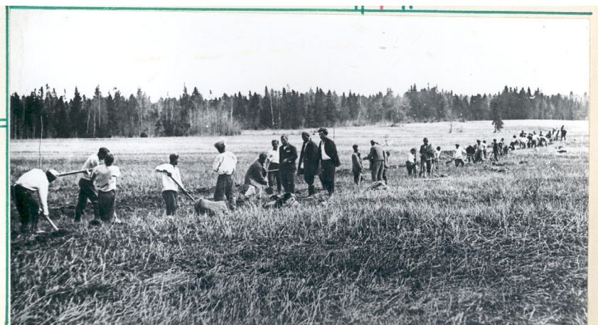
Строительство шоссе Москва – Минск. 1936 г.
