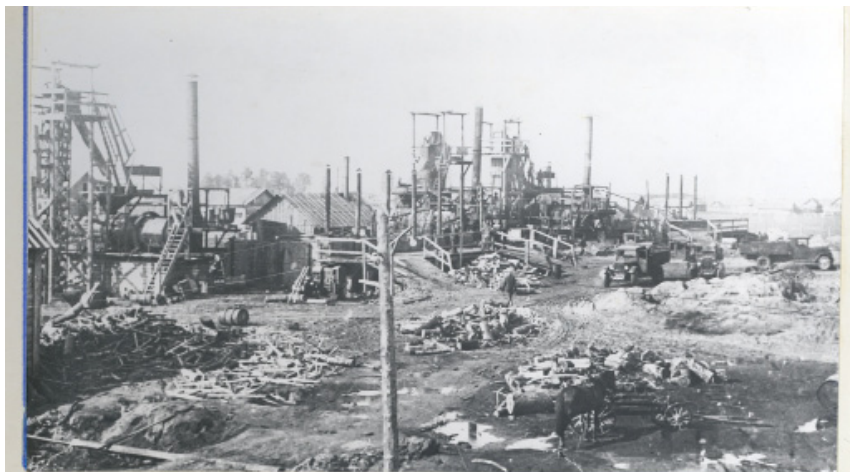
Один из асфальтобетонных заводов Вяземлага. 1939 г.
