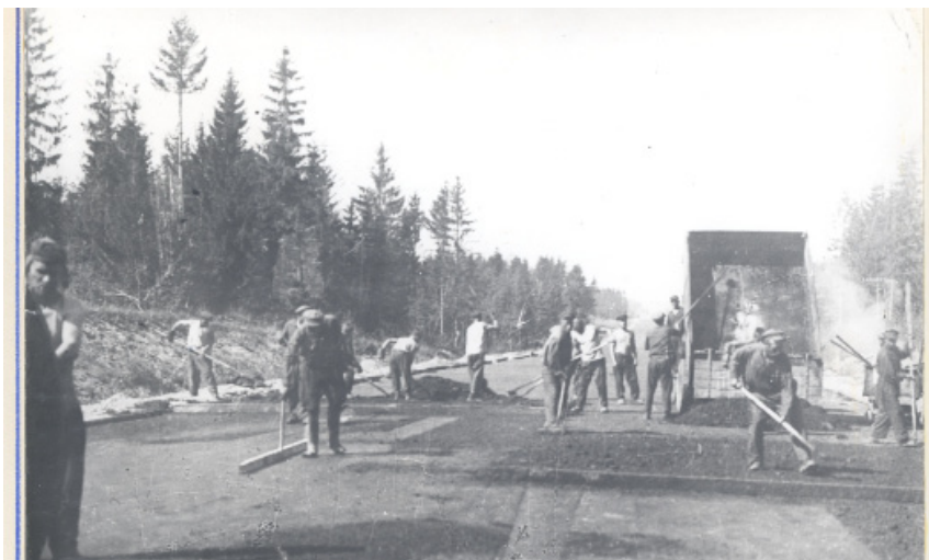
Устройство асфальтобетонного покрытия шоссе Москва – Минск. 1940 г.
