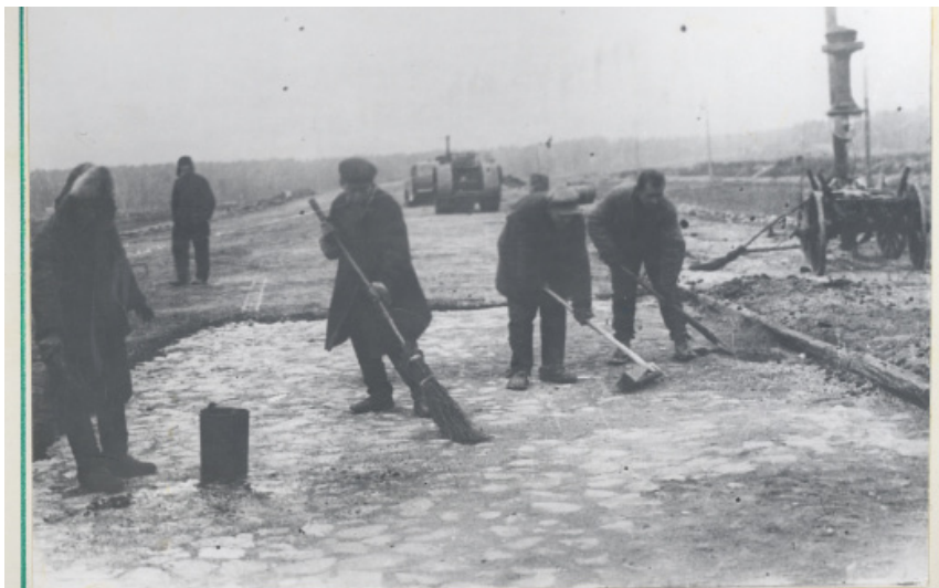
Очистка поверхности перед укладкой асфальтобетона. Шоссе Москва - Минск. 1940 г.
