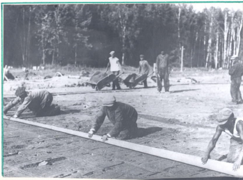
На строительстве автомагистрали Москва – Минск. 1939 г.
