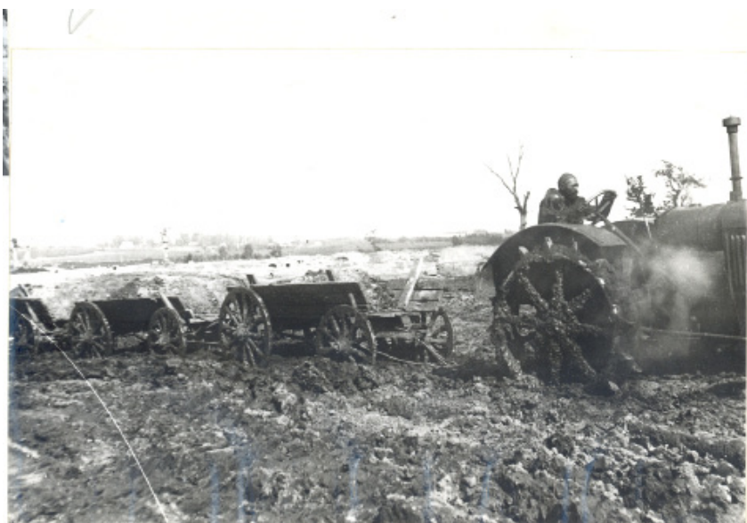
На сооружении шоссе Москва – Минск. Вывоз грунта. 1936 г.
