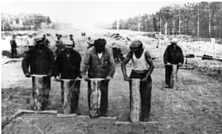
На сооружении шоссе Москва – Минск
