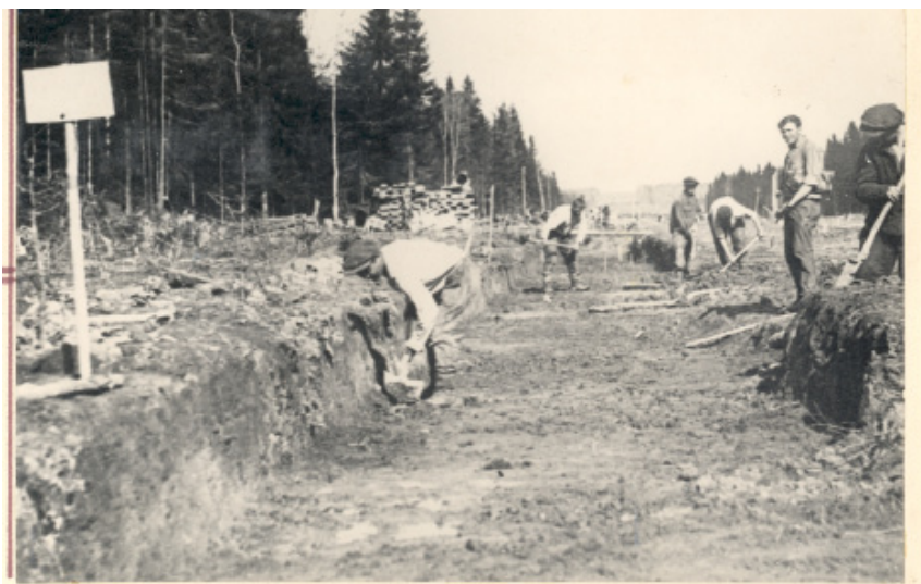
На строительстве автомагистрали Москва – Минск. 1936 г.
