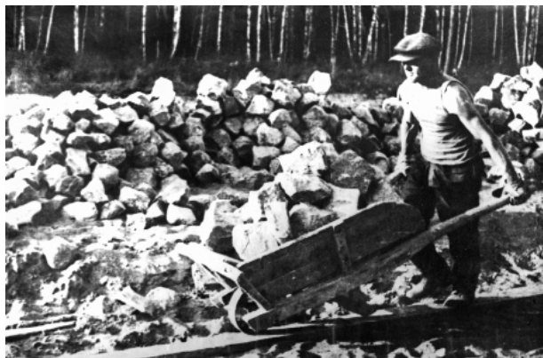
На строительстве автомагистрали Москва – Минск.
