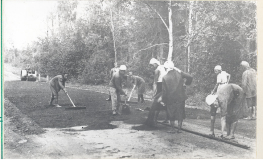
Укладка асфальтобетона на сооружении шоссе Москва – Минск. 1940 г.
