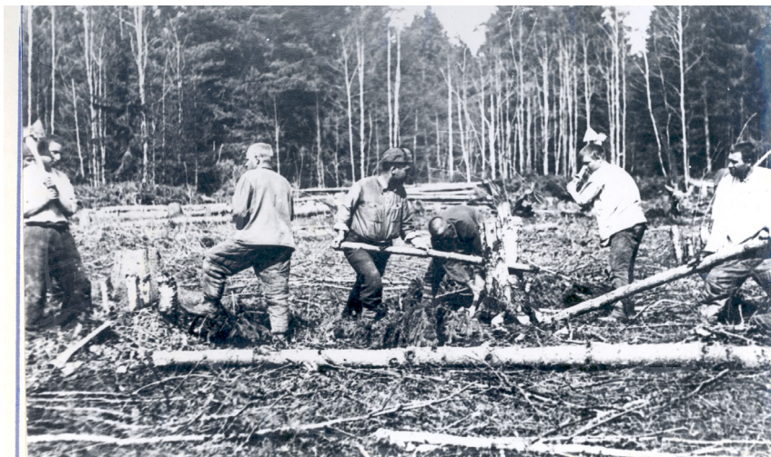
На строительстве дороги Москва – Минск. 1936 г
