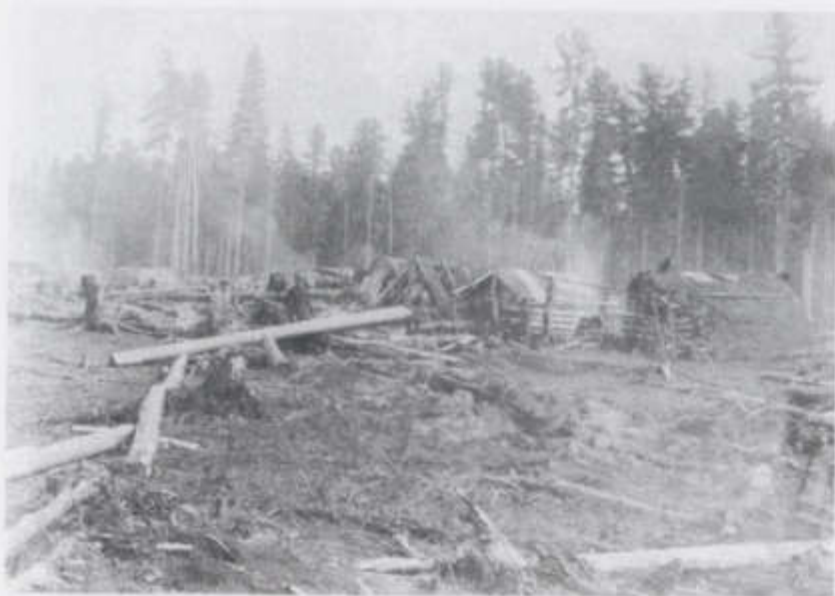
Строительство первых жилищ на раскорчевке у берега Васюгана
