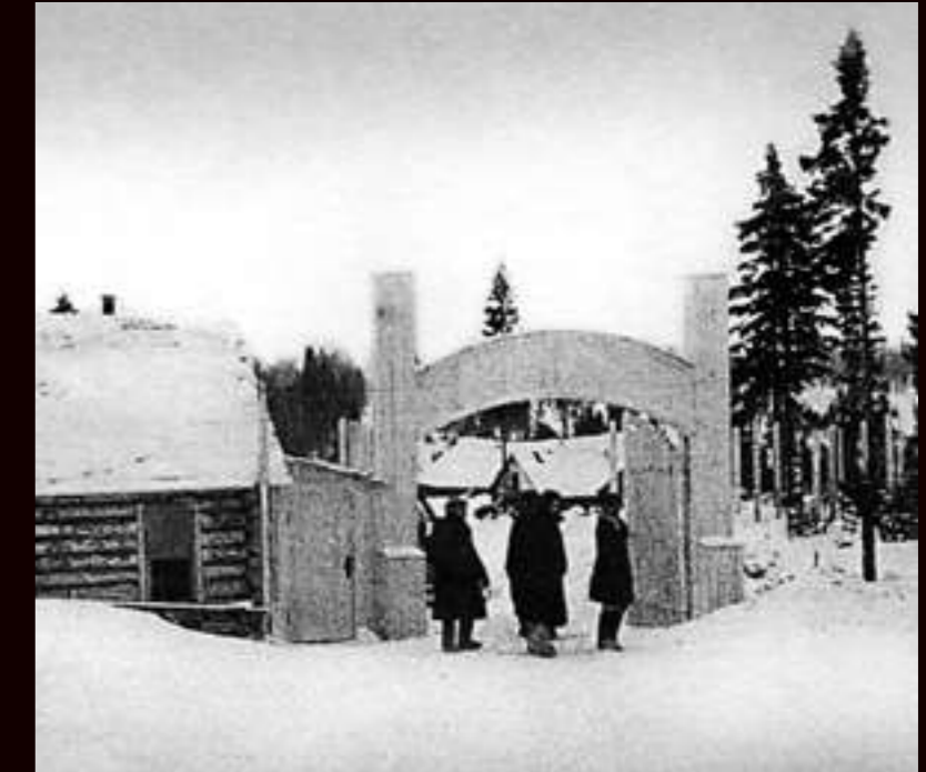
Errichtung der Poryschewskaja Wasserkraftanlage, 1. Abteilung des Poryschlag des NKWD, Wache, Rajon Tschusowaja, 1943.
