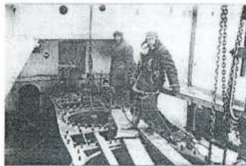
Начальник экспедиции в машинном отделении. Крышки цилиндров уже сняты. Сзади — вновь назначенный вместо убитого бандитами М.Г. Ровнякова — зав. производством, механик И.А. Лойко
