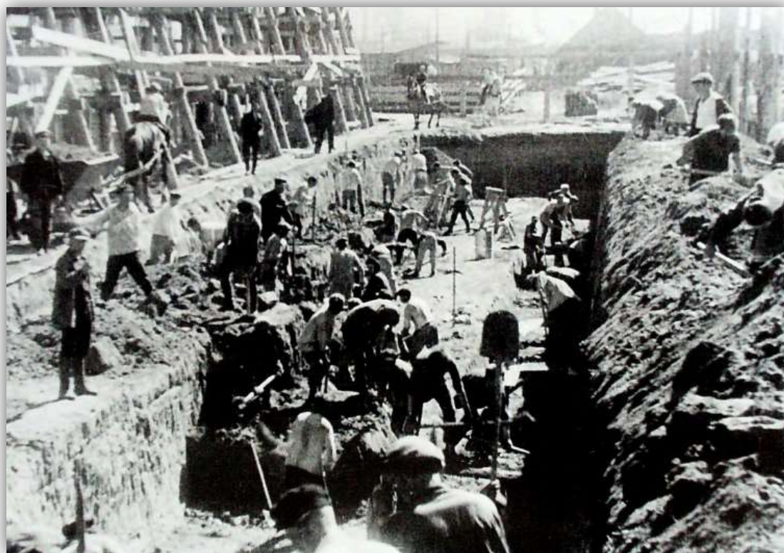
На строительстве котлована ГРЭС
