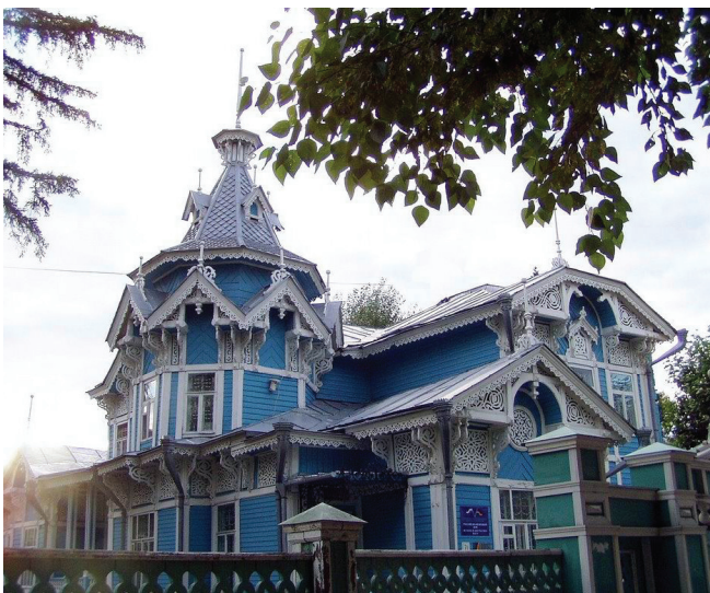
Томск. Ул. Красноармейская, 71. Современный вид
