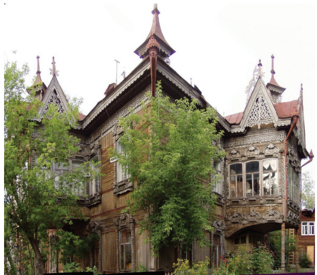
Томск. Ул. Красноармейская, 67. Современный вид
