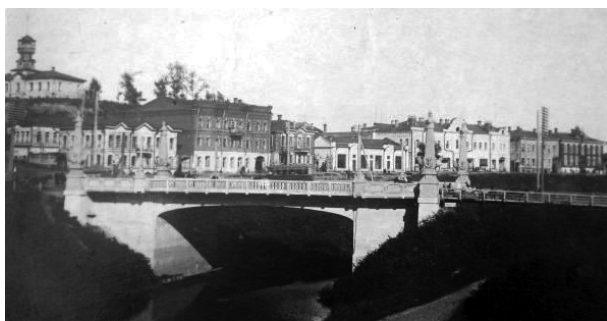
Томск. Каменный мост через Ушайку
