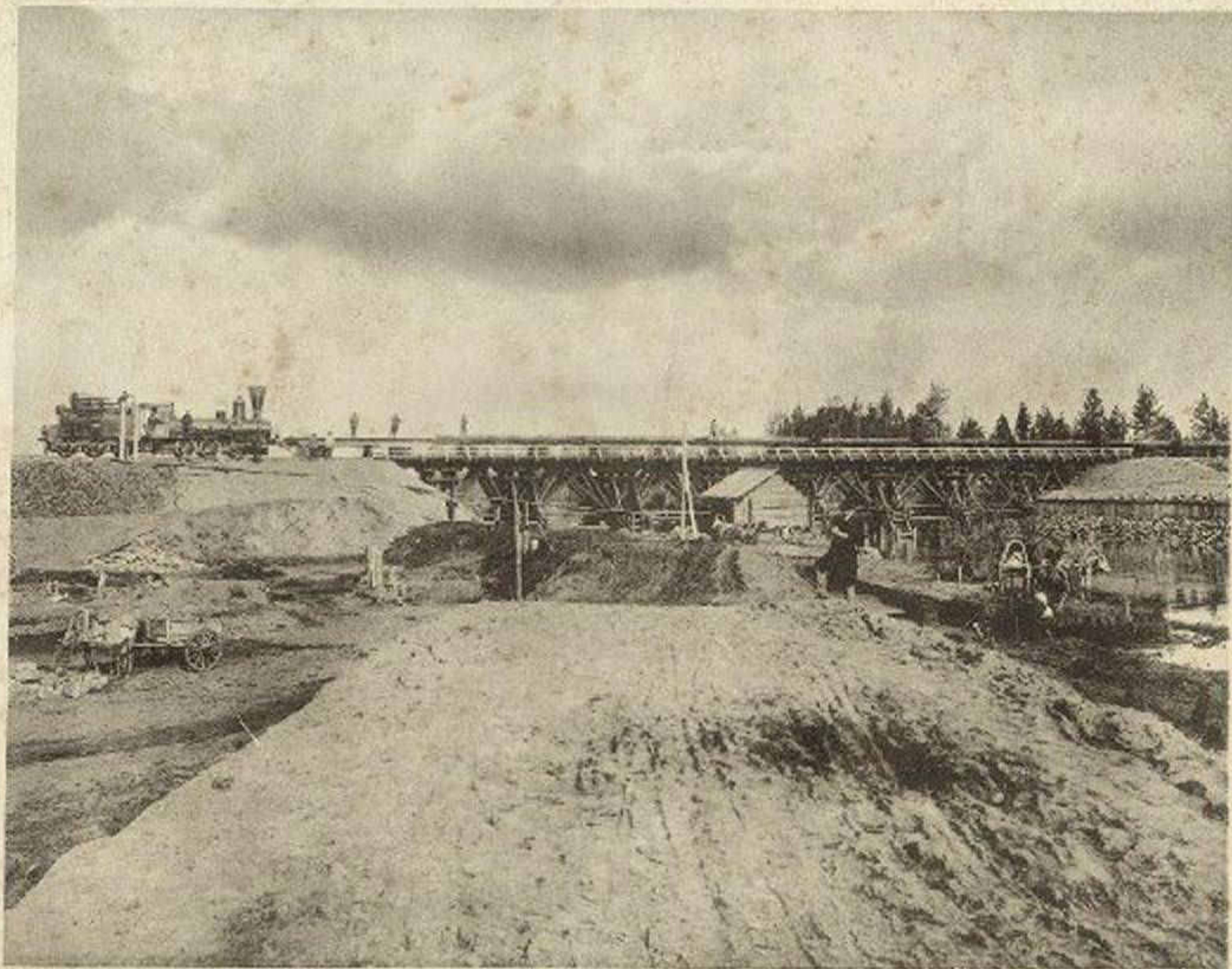
Деревянный мостъ черезъ р. Кимильтей на 744 вер. отъ р. Енисея.
