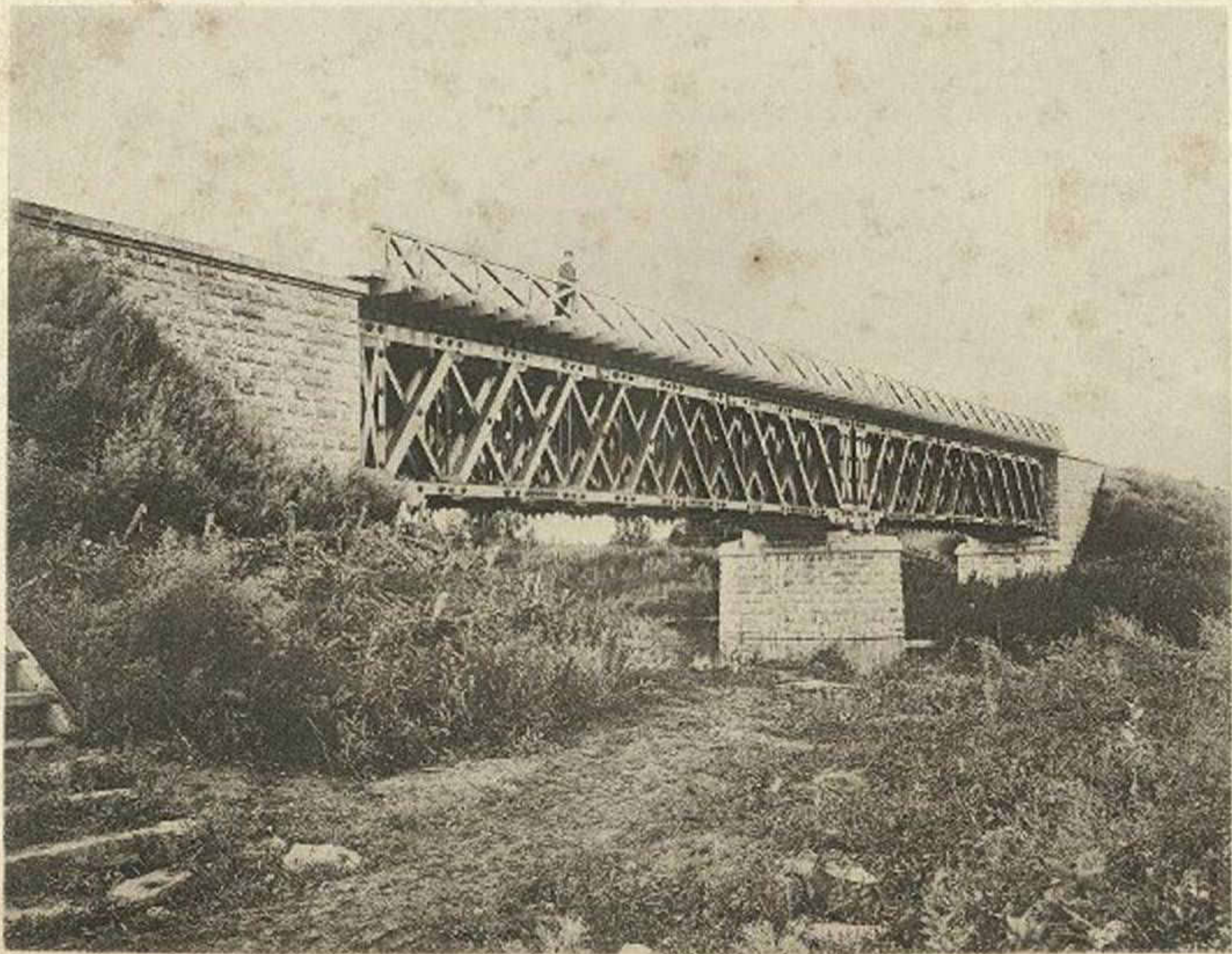
Каменный мостъ черезъ р. Лебяжью на 135 верстѣ отъ р. Оби.
