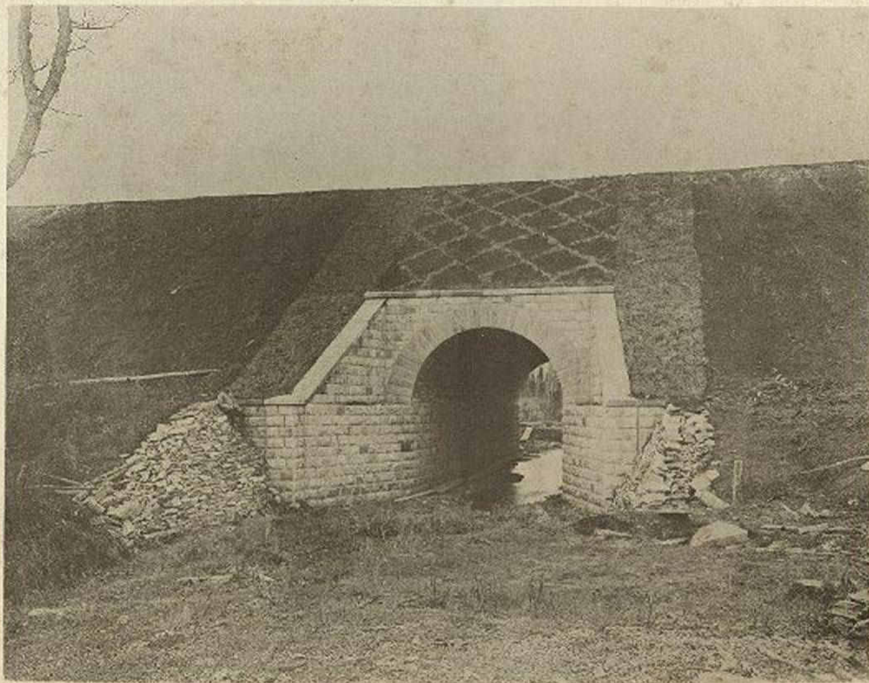
Каменная труба отв. 2,50 сан. на 412 верстѣ отъ р. Оби.
