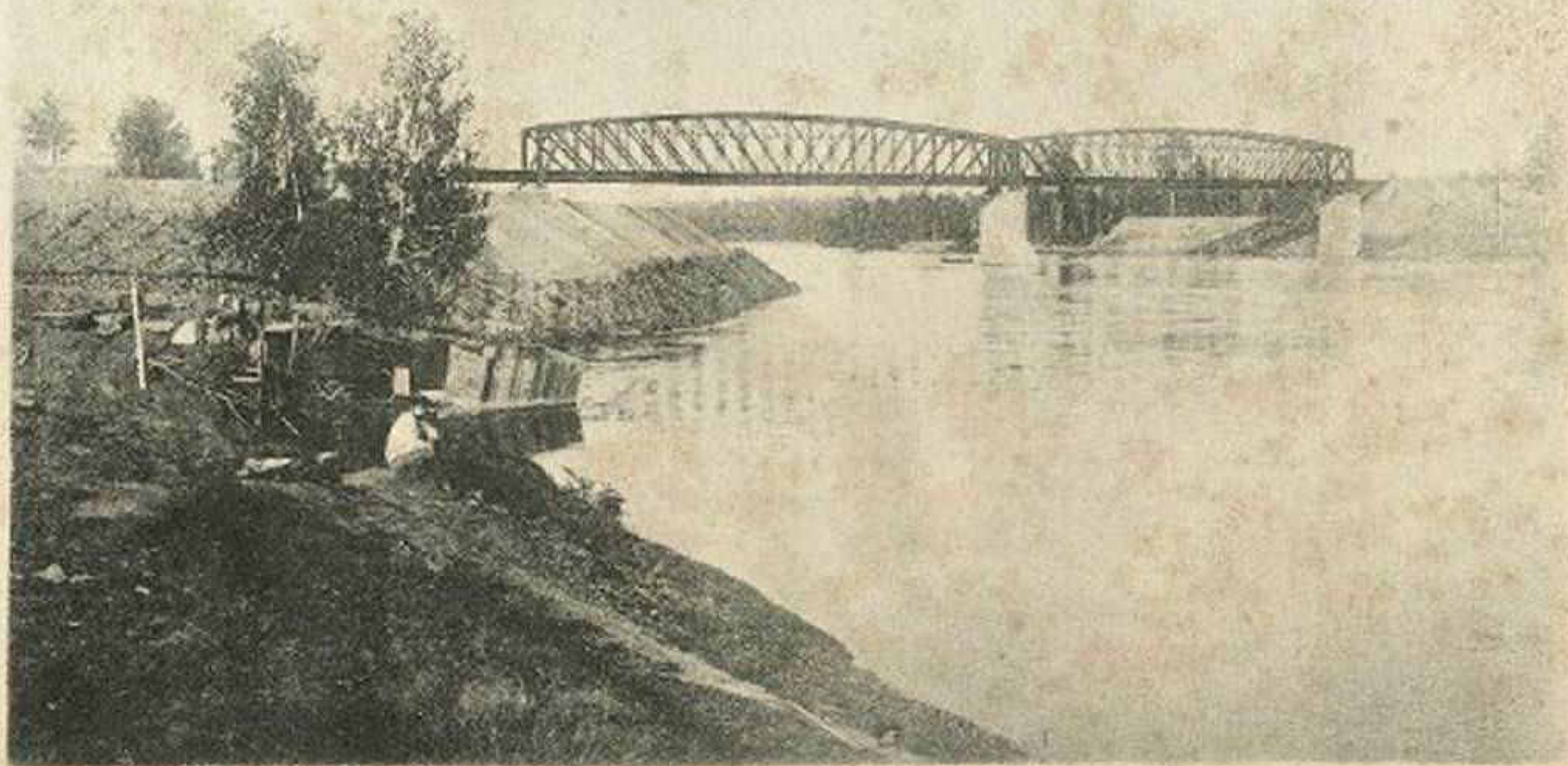
Желѣзный мостъ черезъ р. Ію отв. 80 саж. на 644 вер. отъ р. Енисея.
