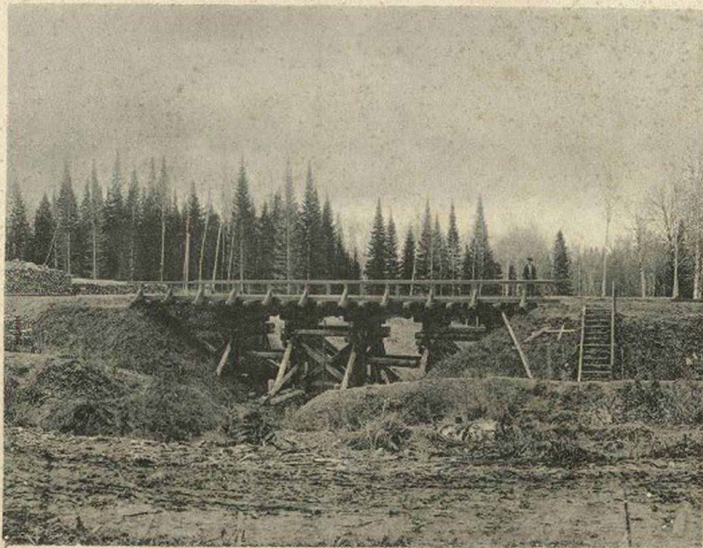
Деревянный мостъ балочной системы на 318 вер. отъ р. Оби.
