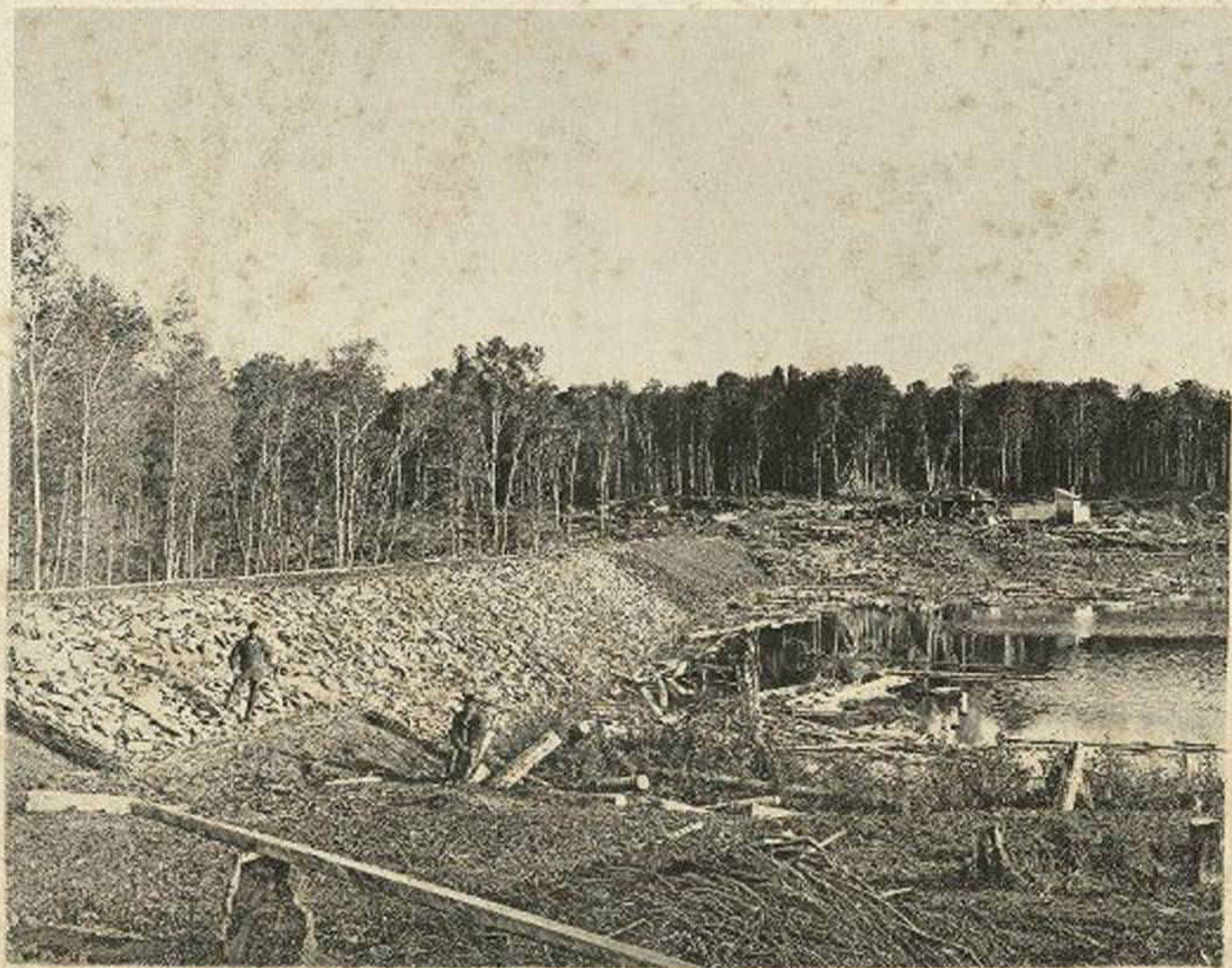
Плотина пруда водоснабженія на ст. Тайга.
