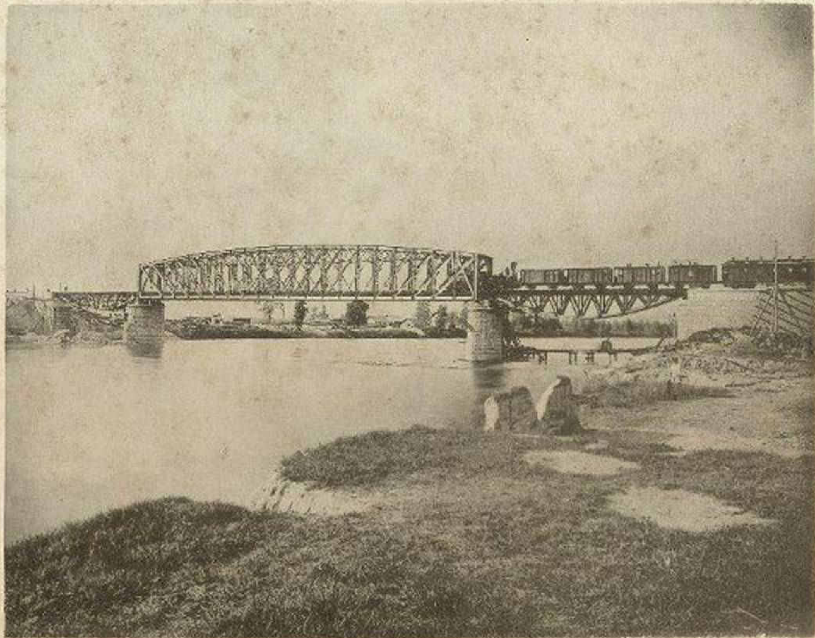
Жельзный мостъ черезъ р. Кнтой отв. 70 саж. на 960 вер. отъ р. Енисея.
