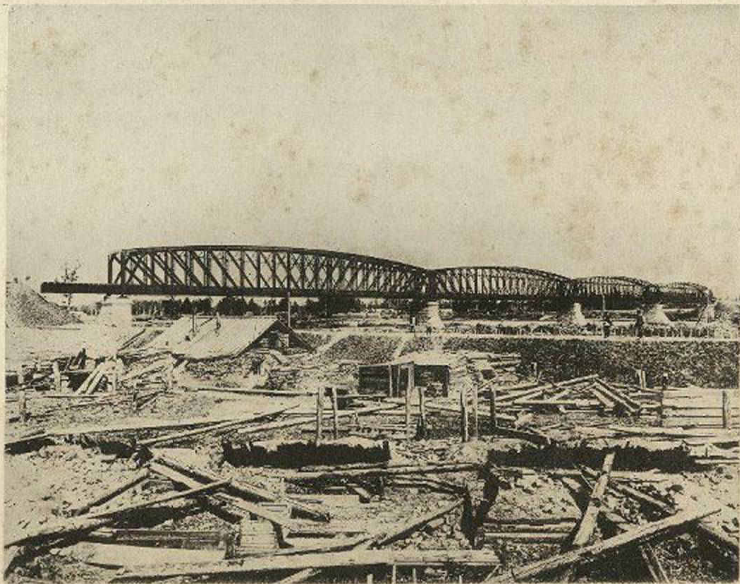
Желѣзный мостъ черезъ р. Бирюсу отв. 160 саж. на 368 вер. отъ р. Енисея.
