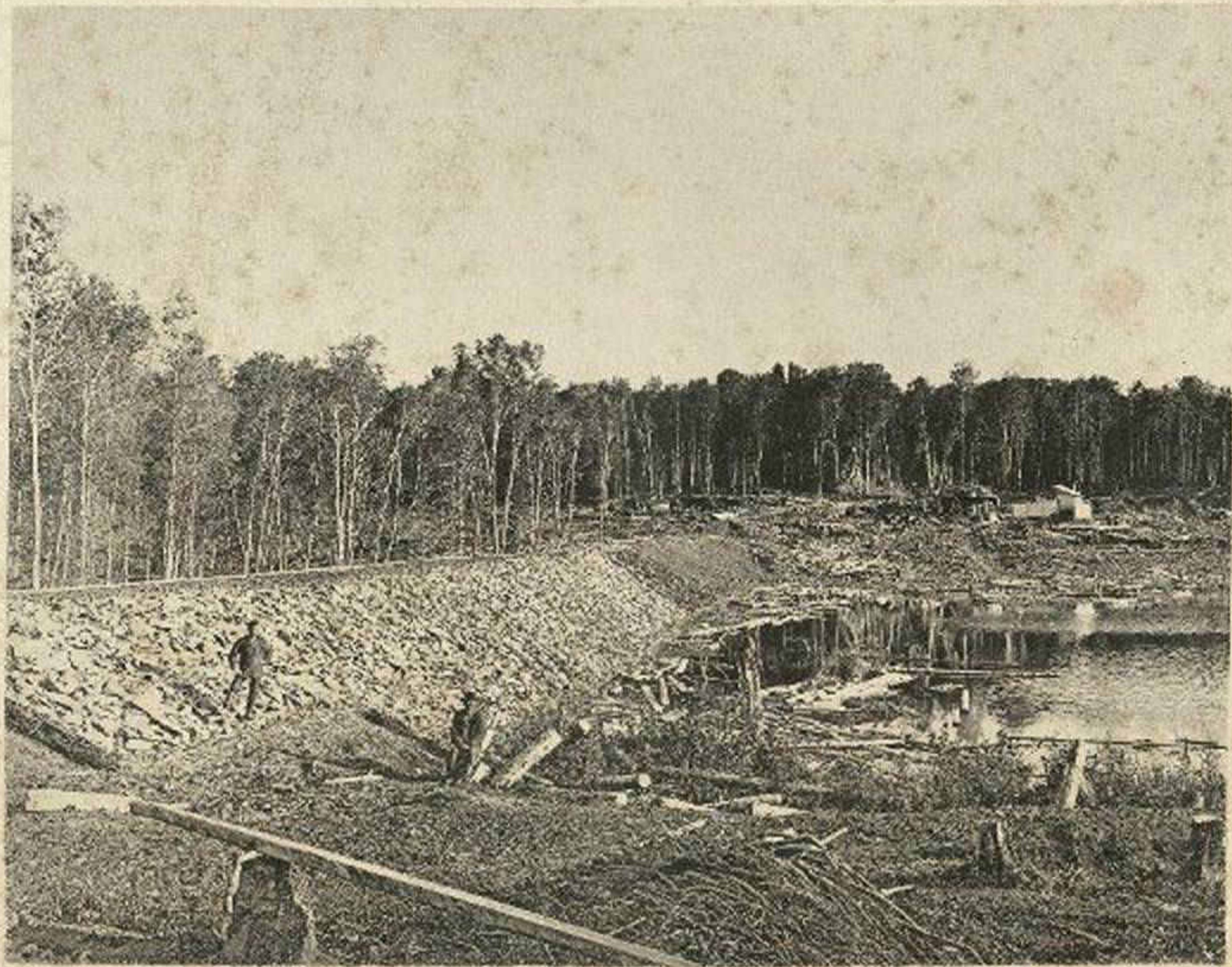
Плотина пруда водоснабженія на ст. Тайга.
