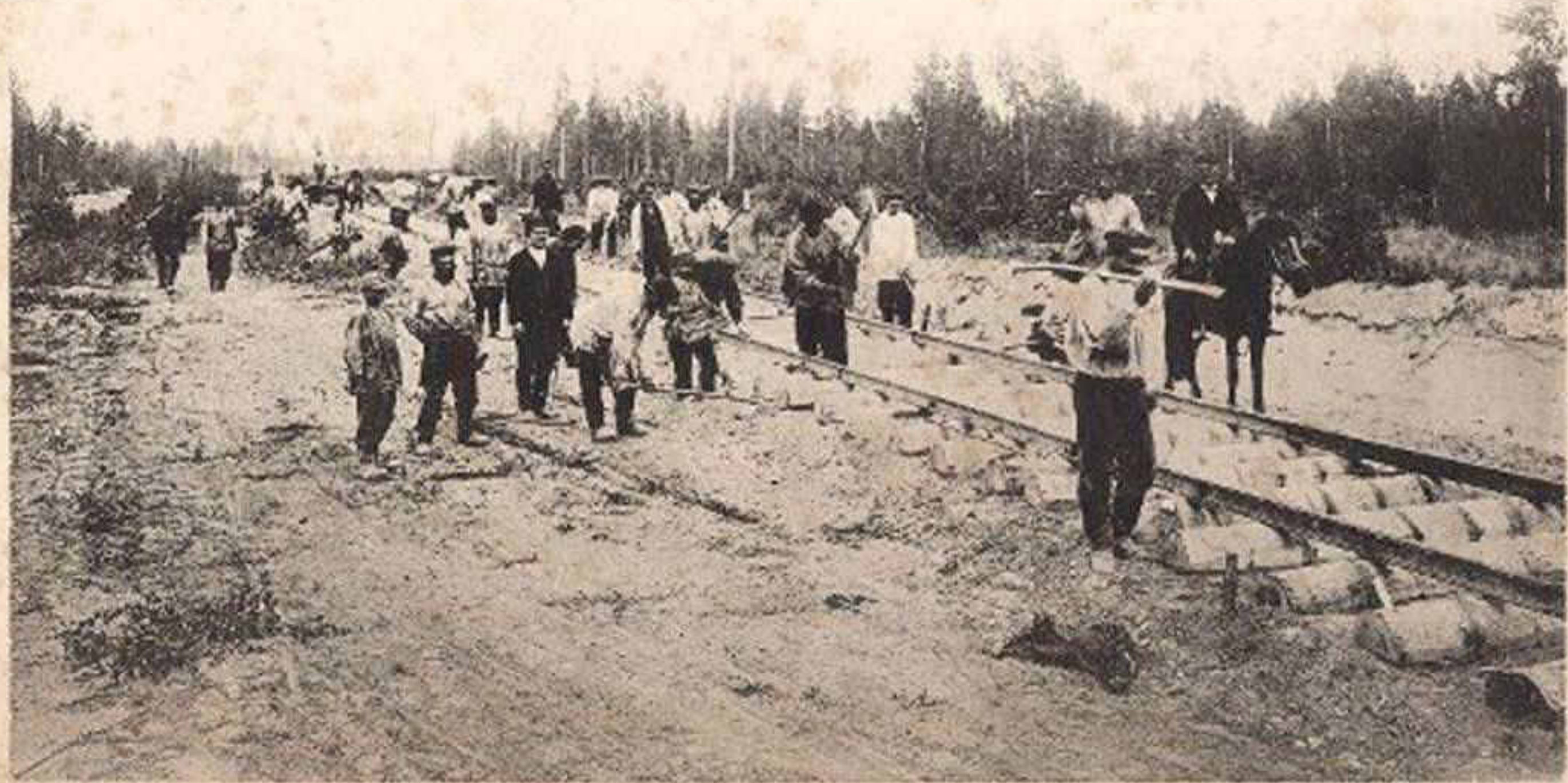
Укладна пути „Костыльщини“
