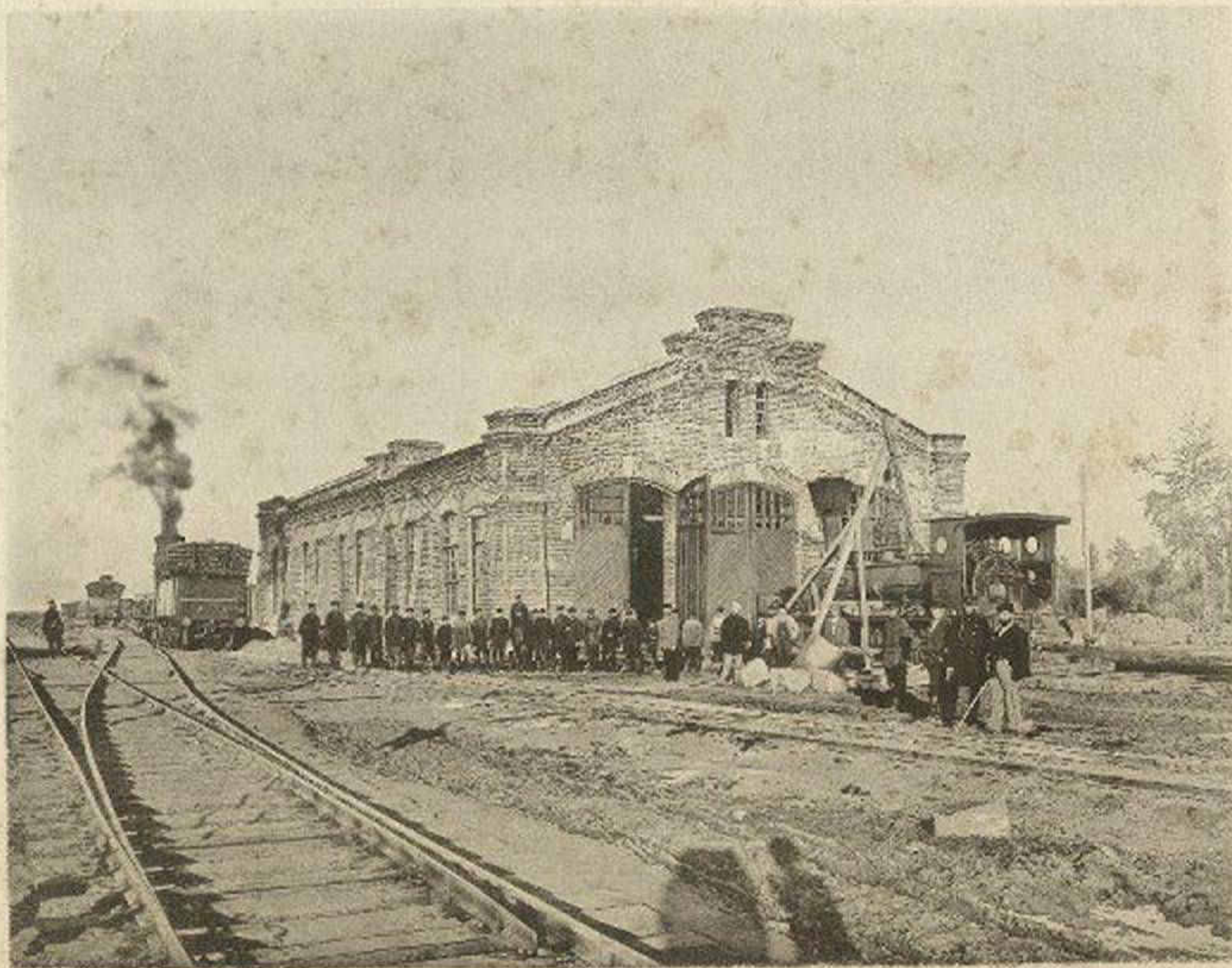
Паровозное здание на ст. Боготолъ.
