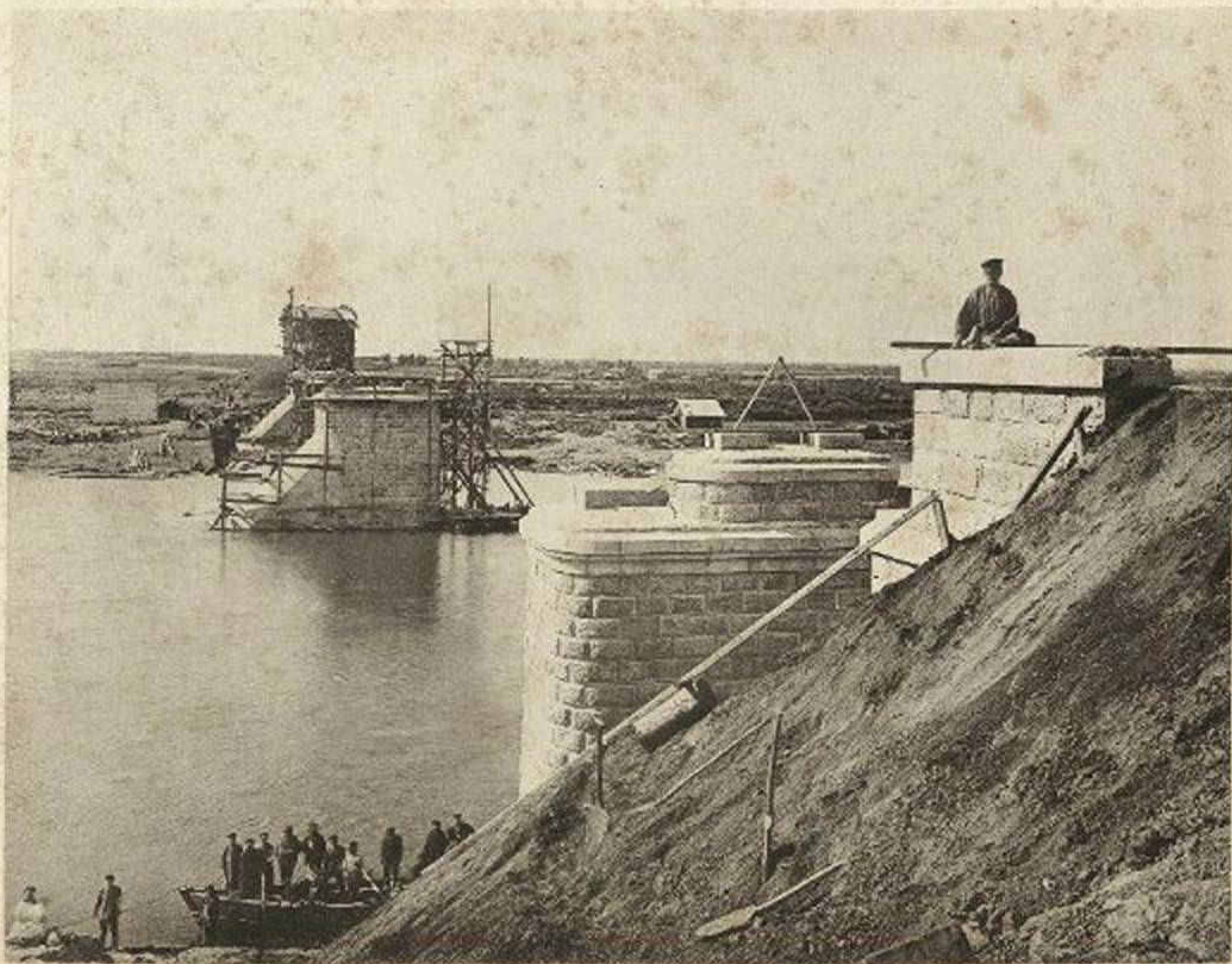
Работы у перехода через р. Чулымъ на 543 верстѣ отъ р. Оби.
