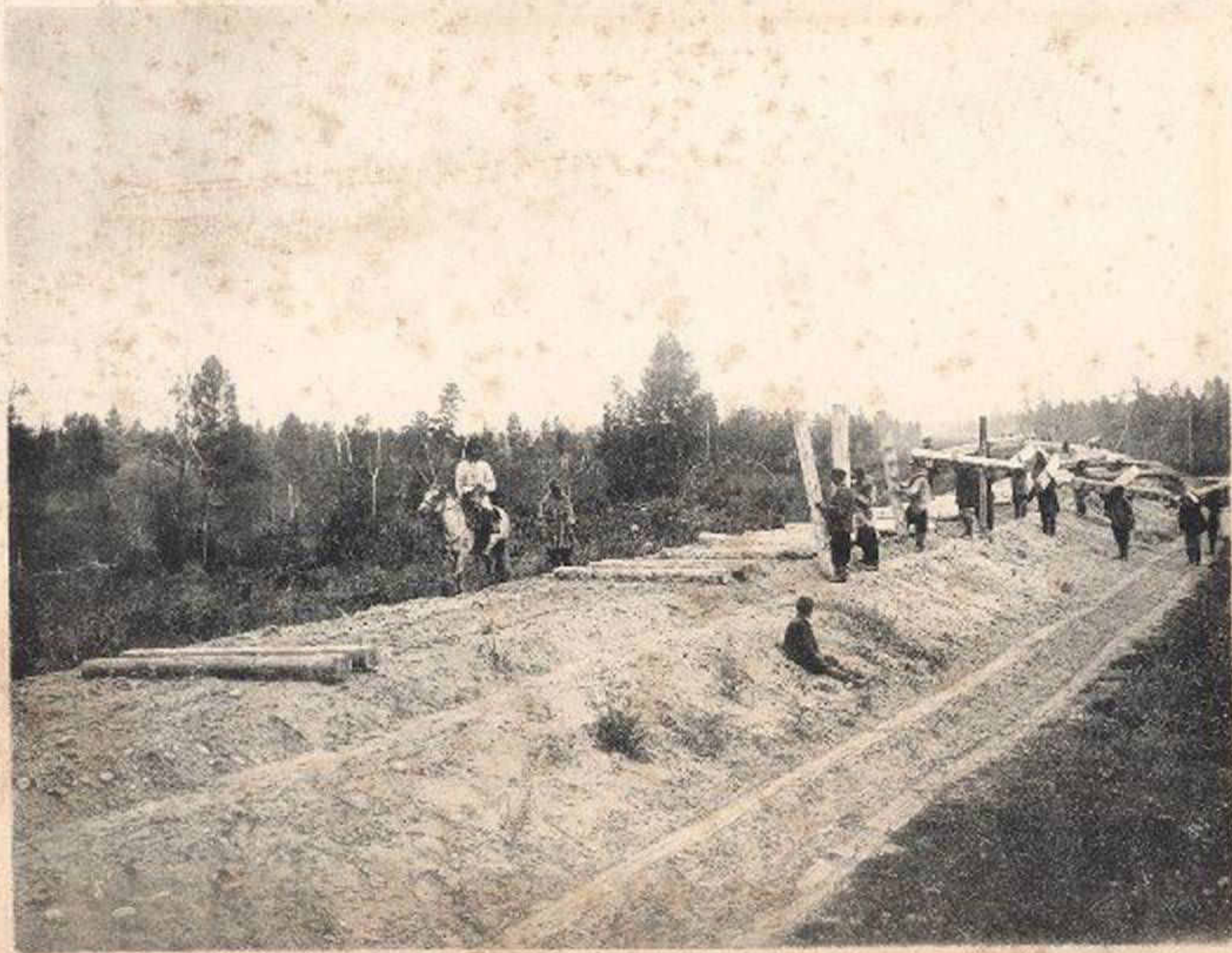
Укладна пути „Шпальщини“
