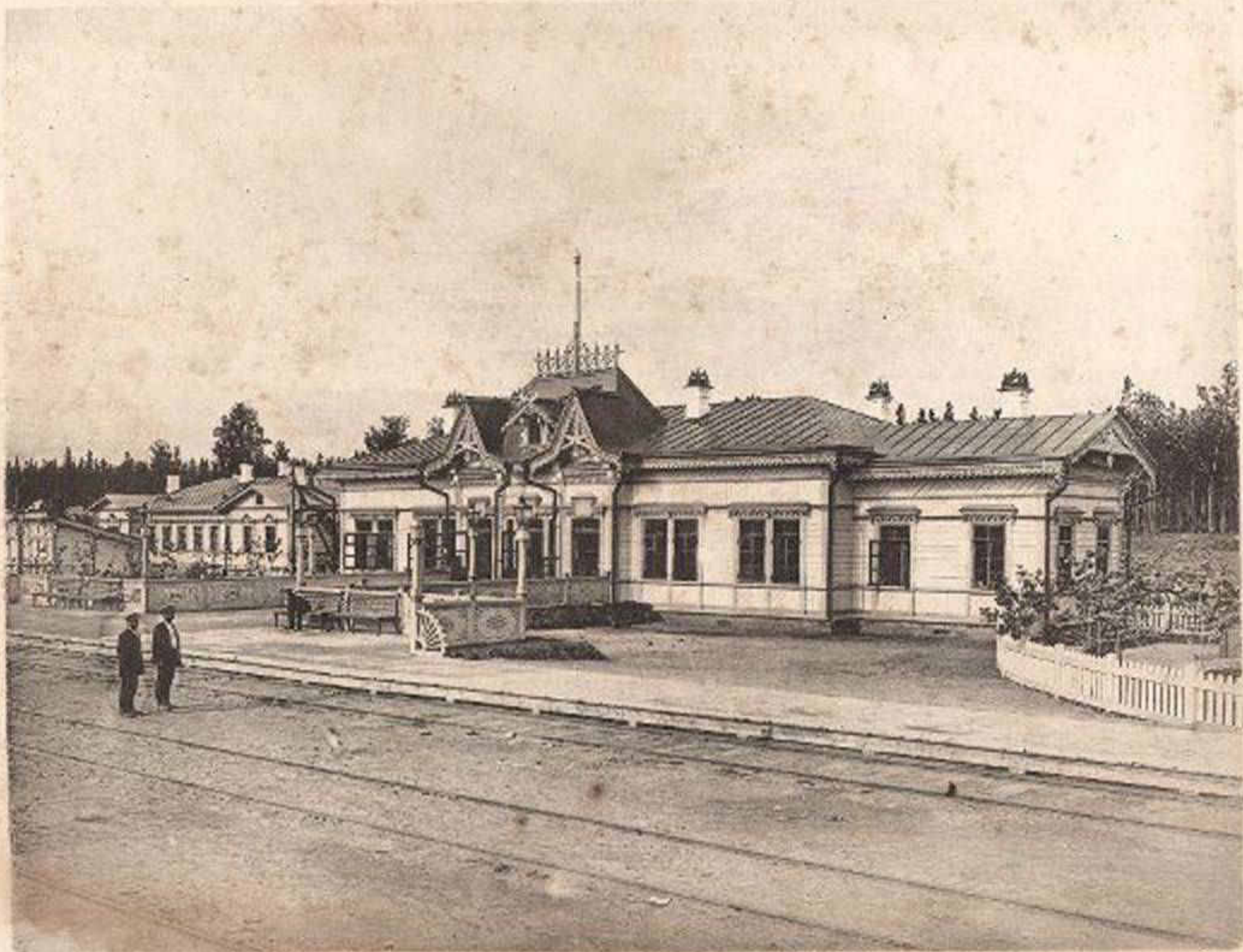
Пассажирское здание на ст. Обь.
