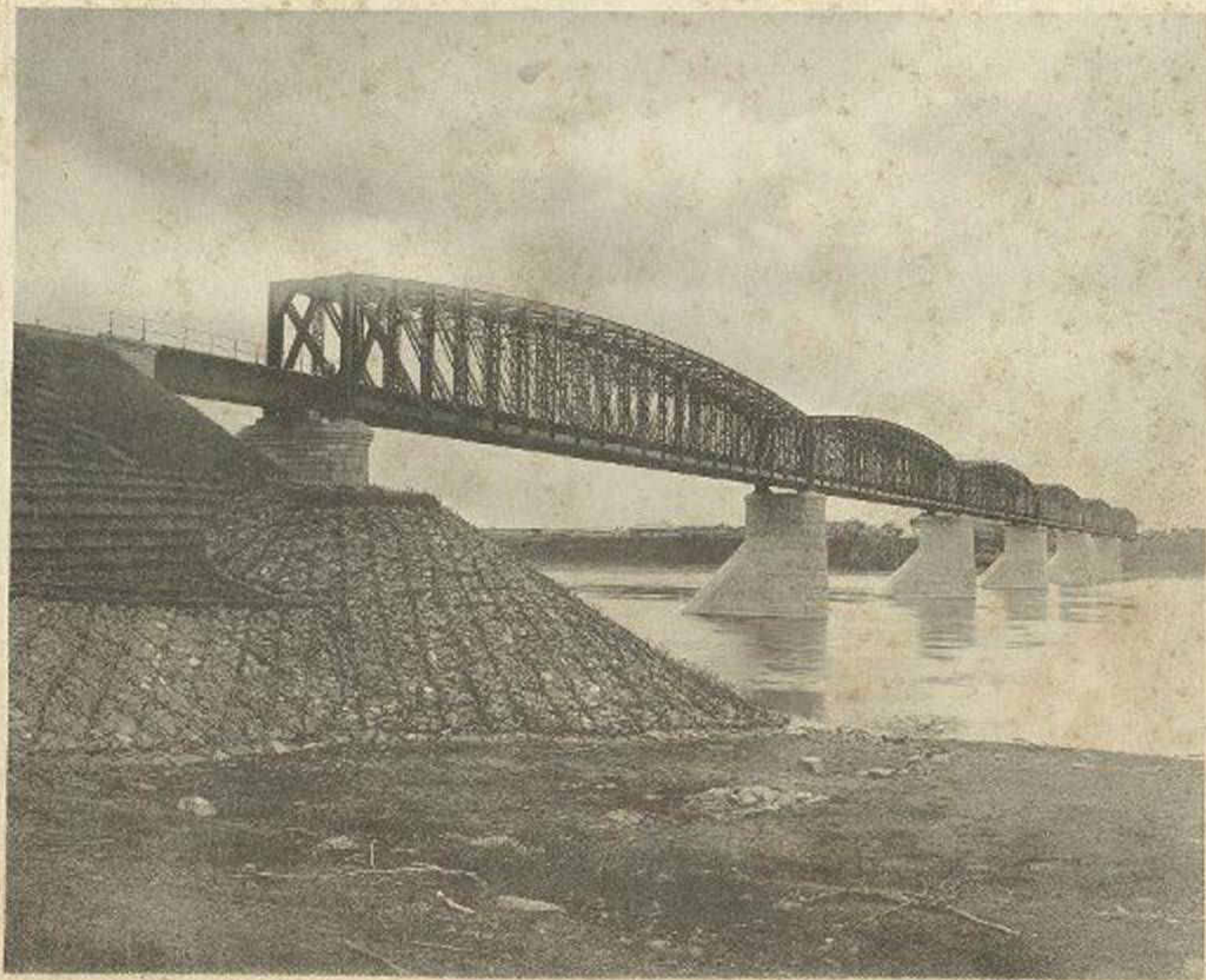
Жельзный мостъ черезъ р. Томь отв. 240 саж. на 156 верстѣ отъ р. Оби.
