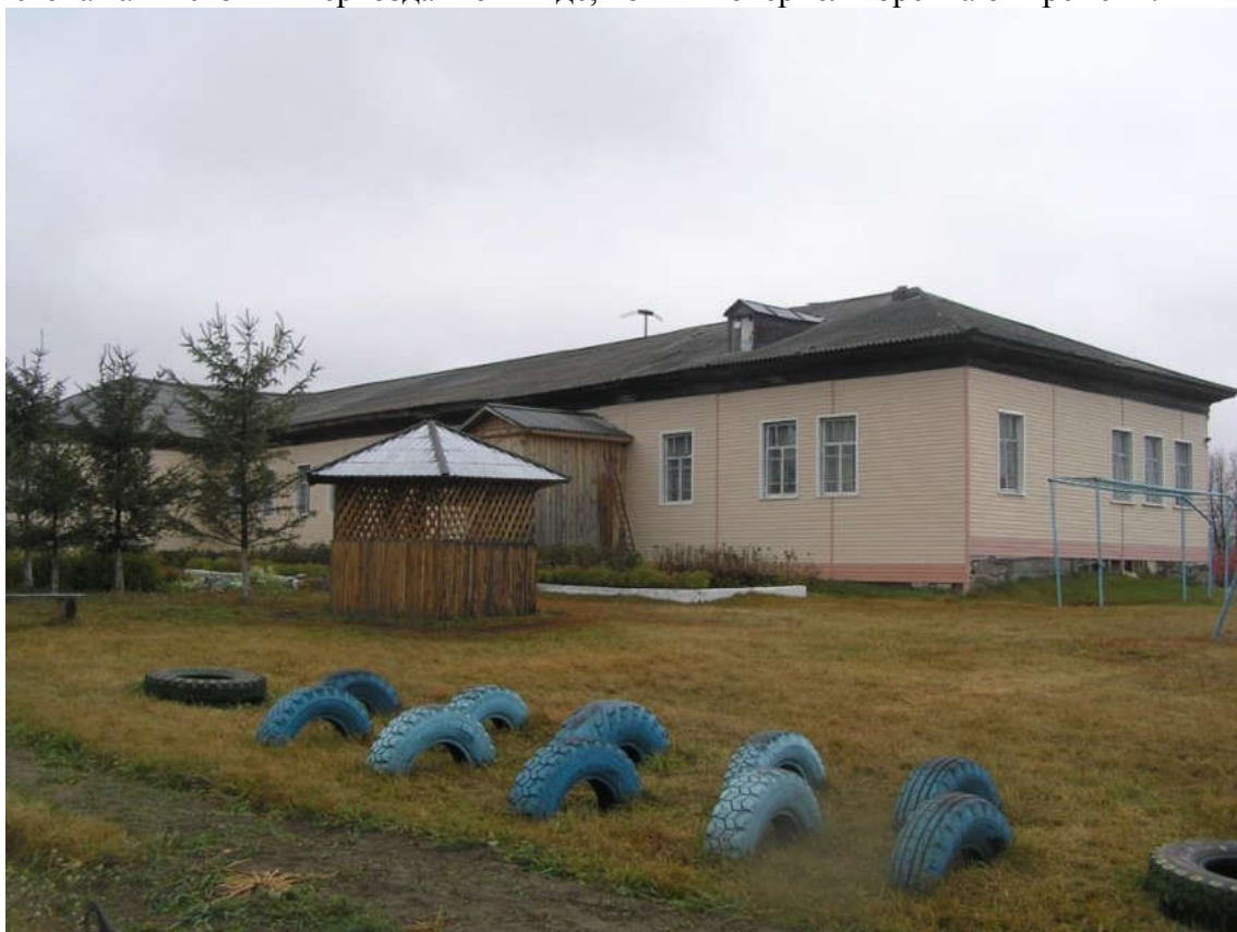
Рисунок 48. Современная школа со стороны фасада (2012)
