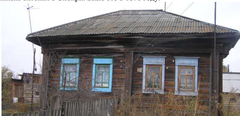
Рисунок 37. Дом этот, срубленный из осины стоит до сих пор. Проживают в нём две разные семьи, что и видно по обрамлению окон. Дом уже с многочисленными переделками (2012)
