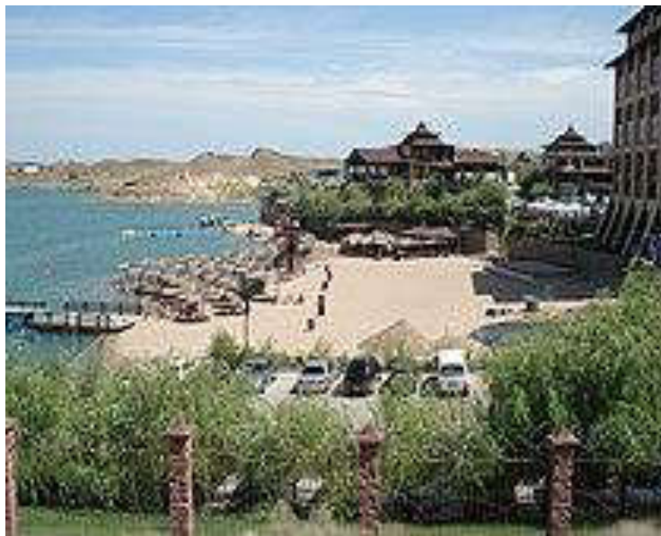
Застройка и захват в частную собственность государственной водоохранной прибрежной зоны водохранилища Капшагай. Фото из открытых источников.
