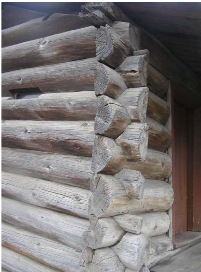
Рисунок 44. Венцы на углу сруба. Свидетельство древних времён. Дому более 120 лет. Брёвна потрескались от воздействия влаги (2012)
