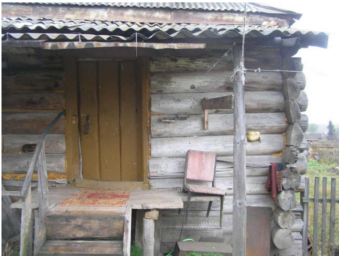
Рисунок 43. Крыльцо хозяев правой половины дома (2012)
