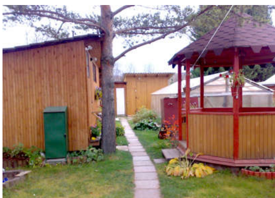
Дача. Летняя кухня, беседка, теплица, туалет, сарай.
