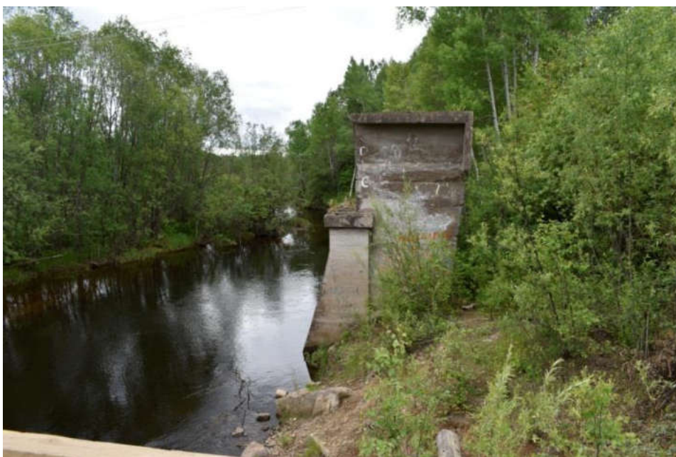
Сохранившиеся с 1953 года береговые опоры моста через реку Бешенную железной дороги правобережья Амура у села Циммермановки.
