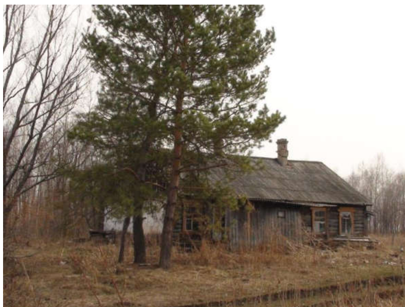
Сохранившаяся казарма строителей железной дороги на участке 59 километра Волочаевка-Комсомольск.
