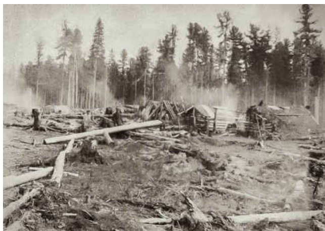
Строительство землянок. 1930-е годы. Источник: фотоархив музея
