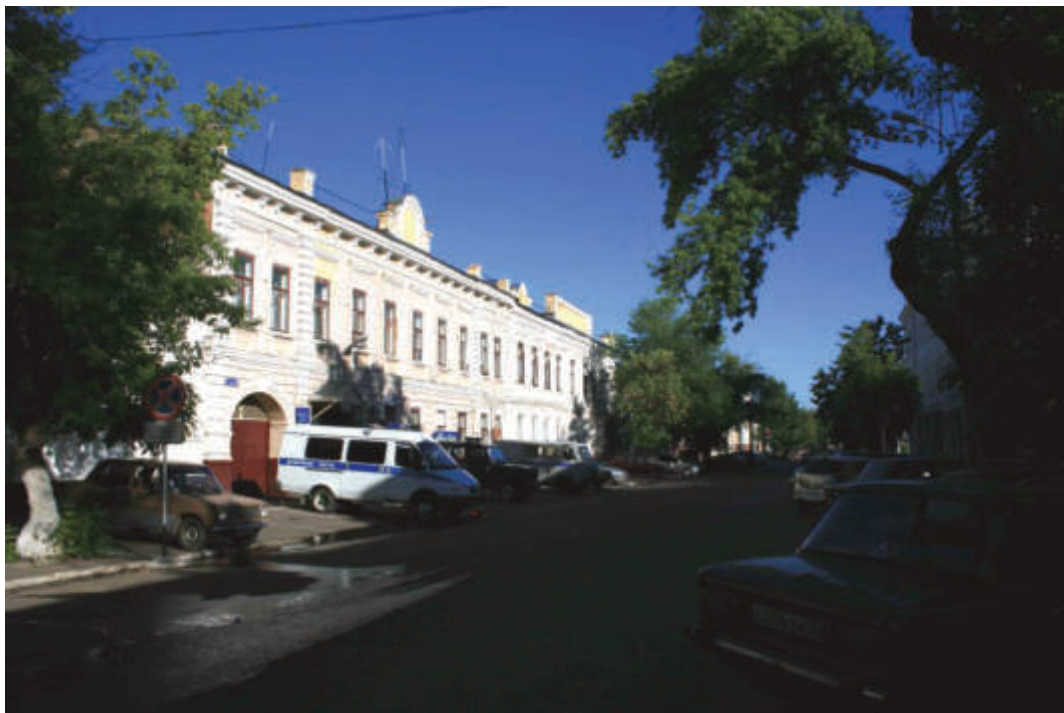
Здание Ленинского РОВД. Расположено напротив здания УФСБ.
