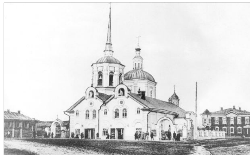
(99) Арестантская церковь Александра Невского. Возвращена верующим в 1992 г. (100) Старый Благовещенский собор. Разрушен.
