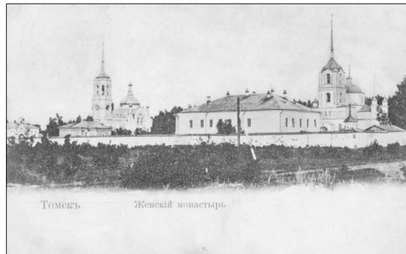
(125) Часовня старца Феодора Томского. Разрушена. (126) Томский женский монастырь. Закрыт и разрушен.
