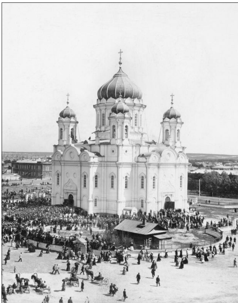
(98) Освящение Троицкого кафедрального собора в 1900 г. Храм разрушен в 1934 г. (Фото из фондов ТОКМ).
