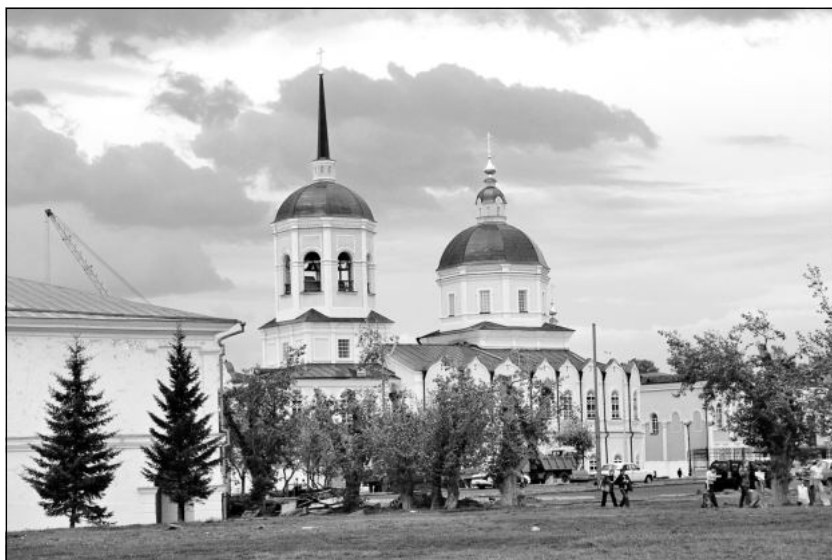
(101) Иверская часовня и Богоявленский храм (Построен в 1784 г.). Разрушены. (102) Богоявленский храм. Восстановлен в 2002 г. и ныне служит кафедральным собором.
