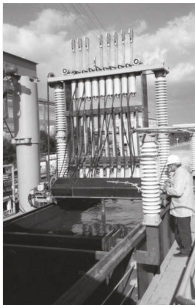
Установка для электроимпульсного разрушения железобетонных конструкций в Японии. Рядом В.Р. Кухта
