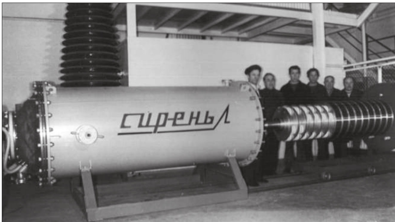
Электронный ускоритель «Сирень» на 1 МэВ с частотой следования импульсов 1 имп./сек
