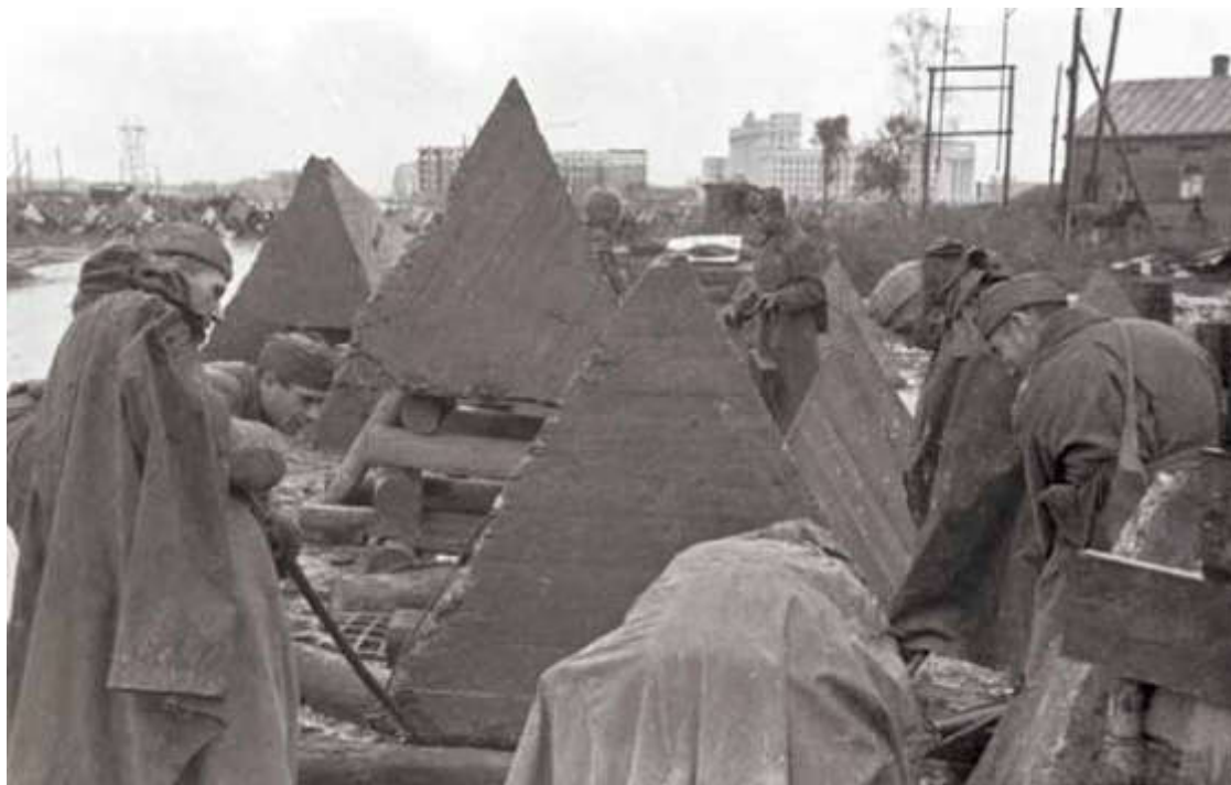
Установка противотанковых железобетонных препятствий на Московском шоссе у Средней Рогатки. Ленинград, октябрь 1941 г. Фотограф В.Г. Федосеев. Из фондов ЦГАКФД СПб.
