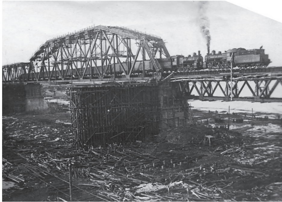
Строительство железной дороги на Воркуту и моста через реку Северную Двину.
